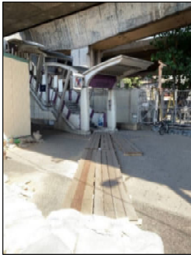
ทางเท้าบริเวณทางขึ้น-ลง ที่สถานีรถไฟฟ้าสะพานตากสิน
