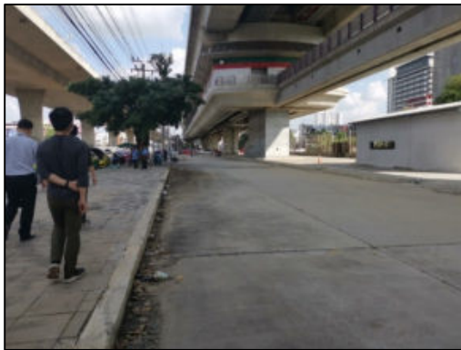
สภาพปัจจุบันที่สถานีรถไฟฟ้ สะพานพระนั่งเกล้า
