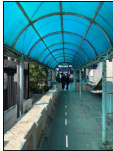
ทางเท้าไม่เสมอกัน ไม่สะดวกต่อการใช้งาน สำหรับบุคคลทั่วไปและผู้ใช้วีลแชร์
