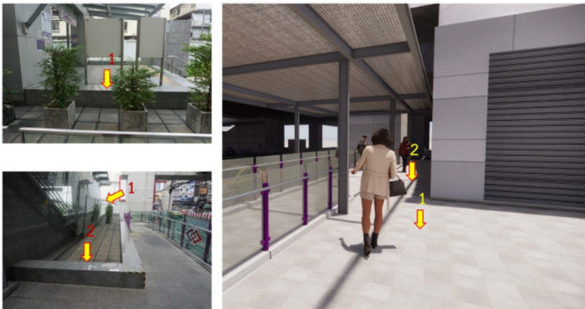
รูปที่ 5.2-3 ยกเลิก CURB ที่อยู่ระหว่างทางลาดผู้พิการกับบันไดทางขึ้น-ลง สถานี
