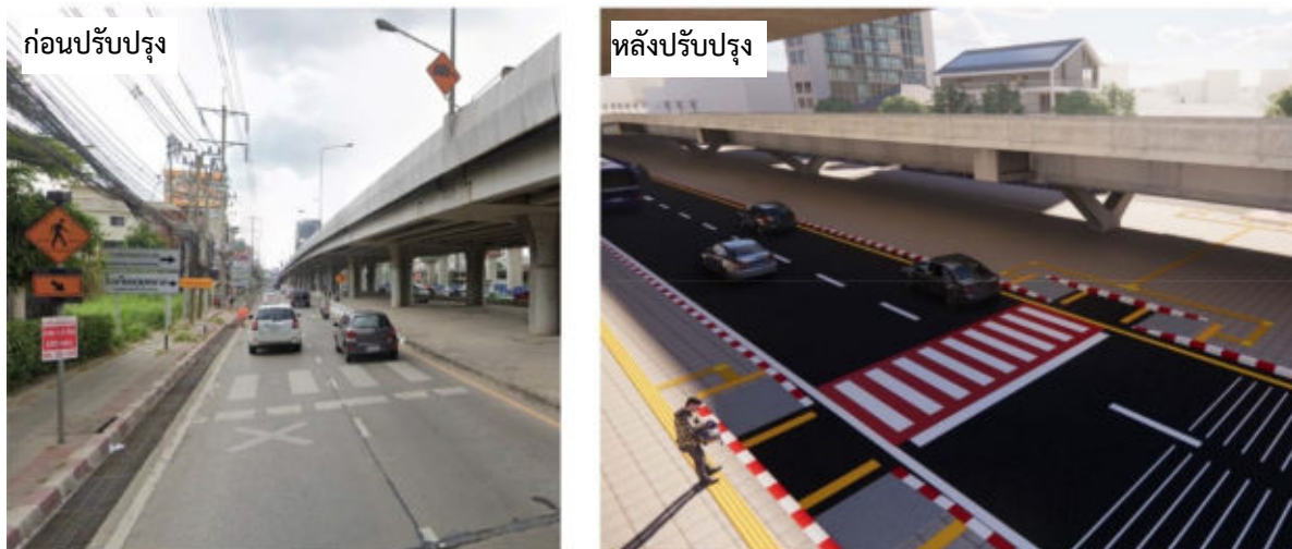
รูปที่ 5.7-3 เพิ่มทางลาดที่ทางม้าลายและเพิ่มสี่เตียนบนถนนให้ชัดเจน
