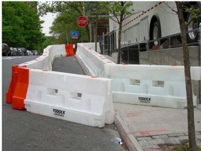
(ข) การติดตั้งแผงกั้นจราจรสำหรับคนเดินเท้า
