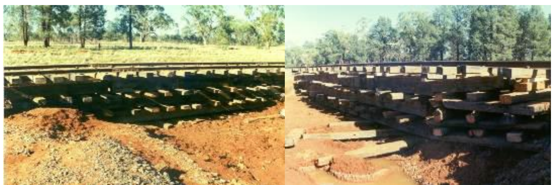
รูปที่ 4-7 การซ่อมคันทางรถไฟชั่วคราวที่ถูกน้ำพัดขาด
