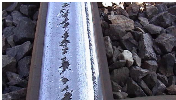
รูปที่ 3-7 เนื้อหลุดลอก (Spalling)
