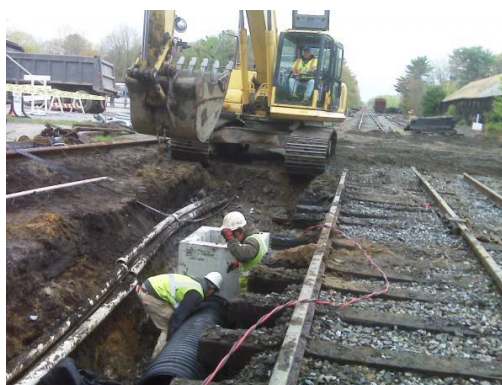
รูปที่ 4-4 ทางรถไฟที่เสียหายจากภัยธรรมชาติ (รูปซ้าย) และการปรับปรุงระบบระบายน้ำ (รูปขวา)
