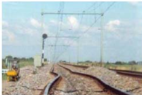
รูปที่ 5-48 การดุ้งของทางรถไฟเนื่องจากแรงภายในรางเชื่อมยาว
