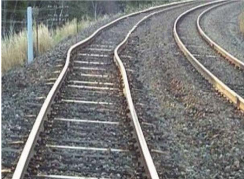
รูปที่ 5-24 การเคลื่อนตัวออกด้านข้างของหมอนและรางเนื่องจากแรงพยุ่งหัวหมอนไม่เพียงพอ (ระยะหินหัวหมอนต่ำเกินไป)
