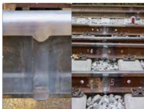
รูปที่ 5-64 แนวเชื่อมเทอมิตหลังจากตัดแต่งแนวแล้ว
