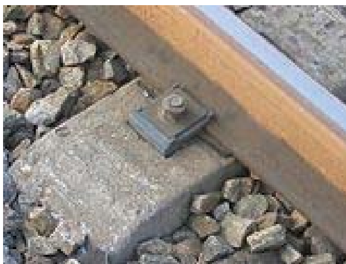
รูปที่ 5-95 ตัวอย่างระบบเครื่องยึดเหนี่ยวรางแบบ Bolt Clamped Fastening
