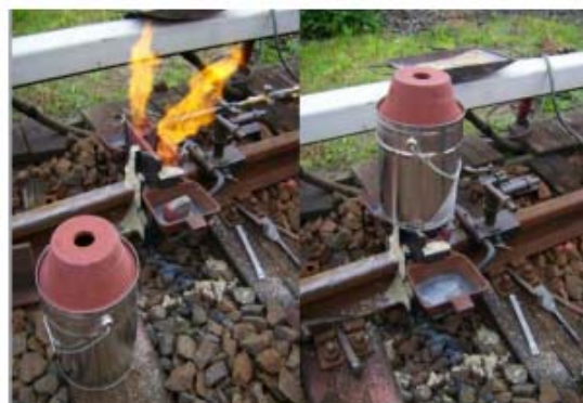
รูปที่ 5-62 การให้ความร้อนก่อนเชื่อม การจัดตำแหน่งกระบอกหลอมพร้อมการป้องกันรั่วปฏิกิริยาและการสิ้นสุดของกระบวนการเชื่อม
