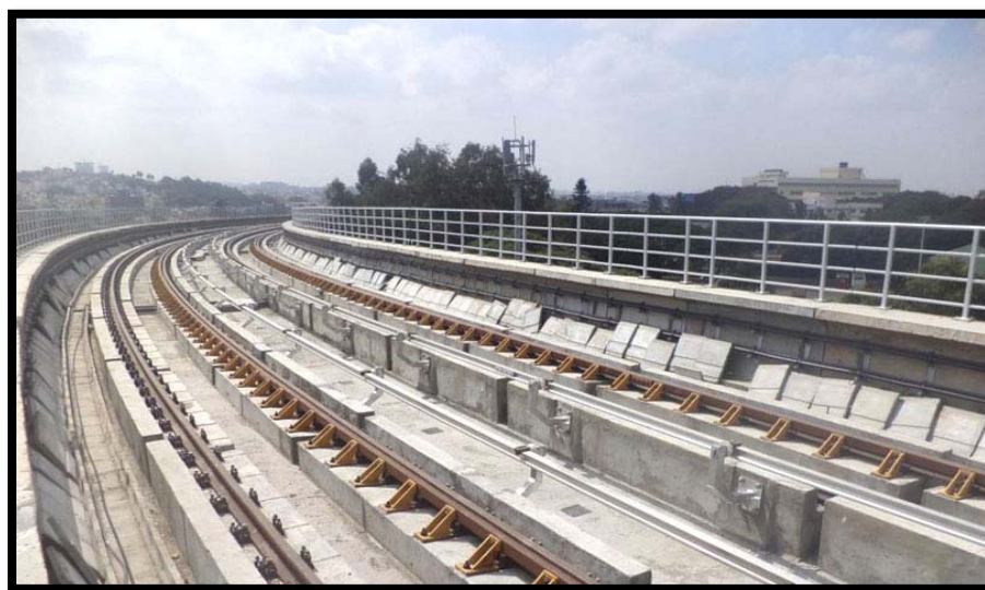
รูปที่ 5-37 ทางรถไฟแบบแท่นคอนกรีตตัวอย่างที่ 2
