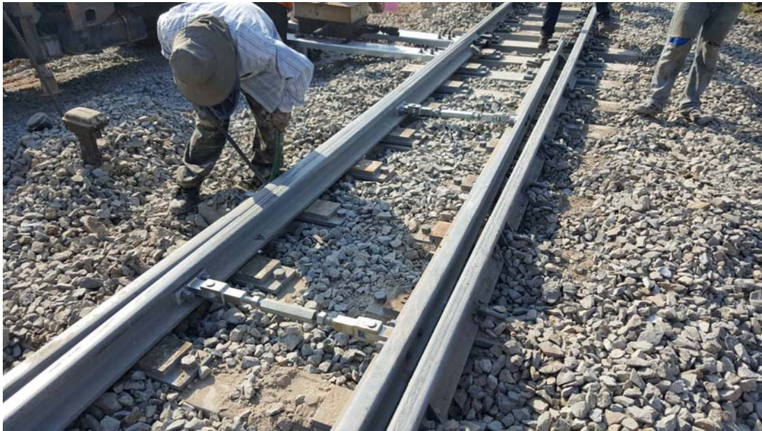
รูปที่ 5-134 การปรับรางสำหรับประแจใหม่
