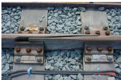
รูปที่ 5-50 Expansion Devices ตามมาตรฐาน UIC 54
