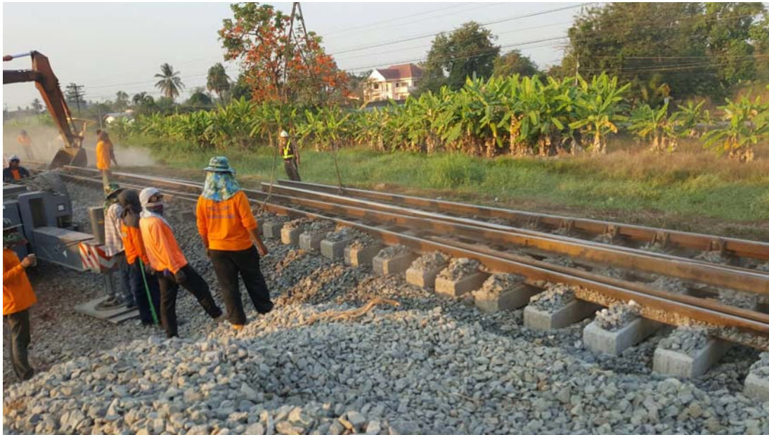
รูปที่ 5-130 การเตรียมการถอดประแจเดิมออกจากทางรถไฟ
