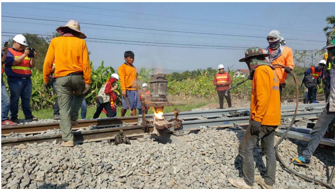
รูปที่ 5-135 การเชื่อมประแจใหม่เข้ากับรางเดิม
