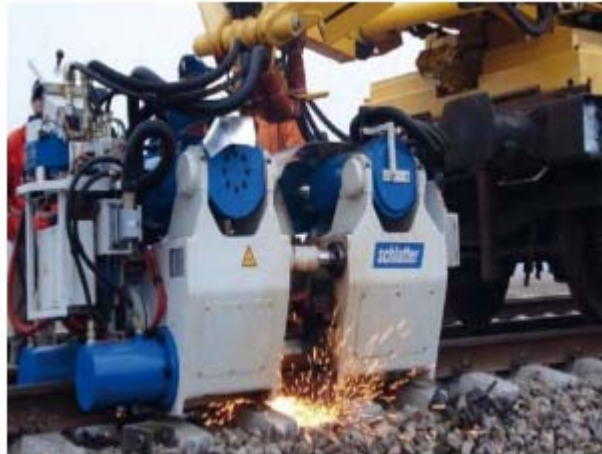
รูปที่ 5-56 เครื่องเชื่อมต่อนเคลื่อนที่บนรางรถไฟ
