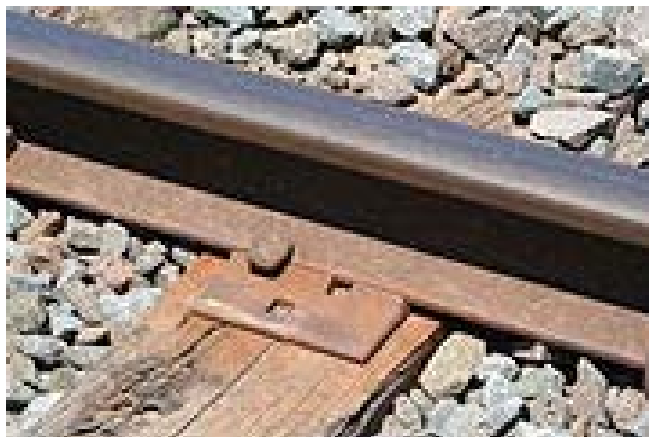
รูปที่ 5-87 แสดงการให้หมุดร่วมกับแผ่นแพลตเพื่อยึดราง
