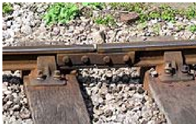
รูปที่ 5-89 เครื่องยึดเหนี่ยวรางบนหมอนไม้ที่ใช้สำหรับบริเวณรอยต่อของราง
