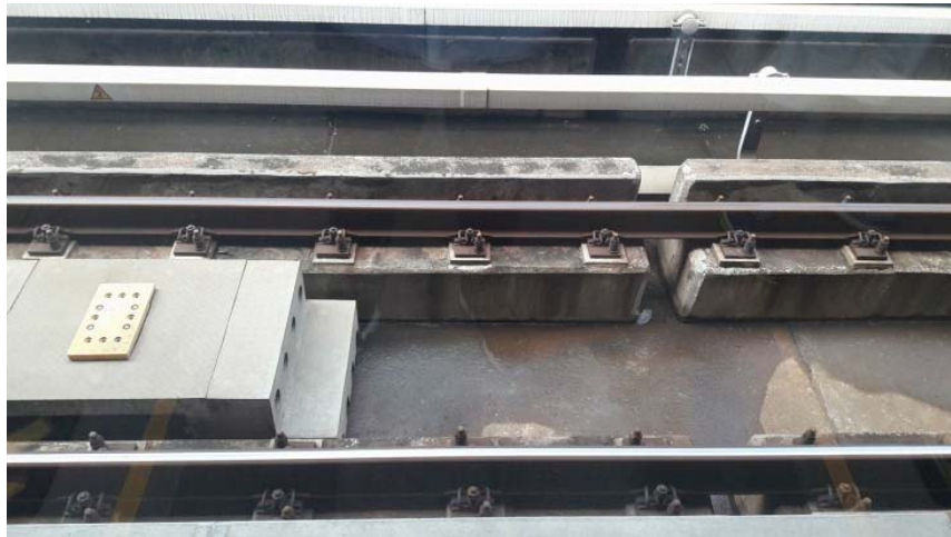
รูปที่ 5-36 ทางรถไฟแบบแท่นคอนกรีตตัวอย่างที่ 1
