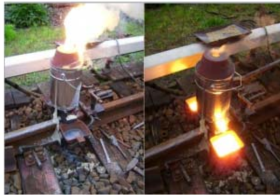
รูปที่ 5-63 ขั้นตอนของการเชื่อมเทอมิต
