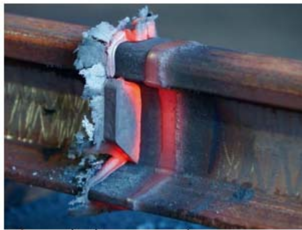
รูปที่ 5-59 แนวเชื่อมเมื่อตัดเศษออกด้วยเครื่องตัดเฉพาะ
