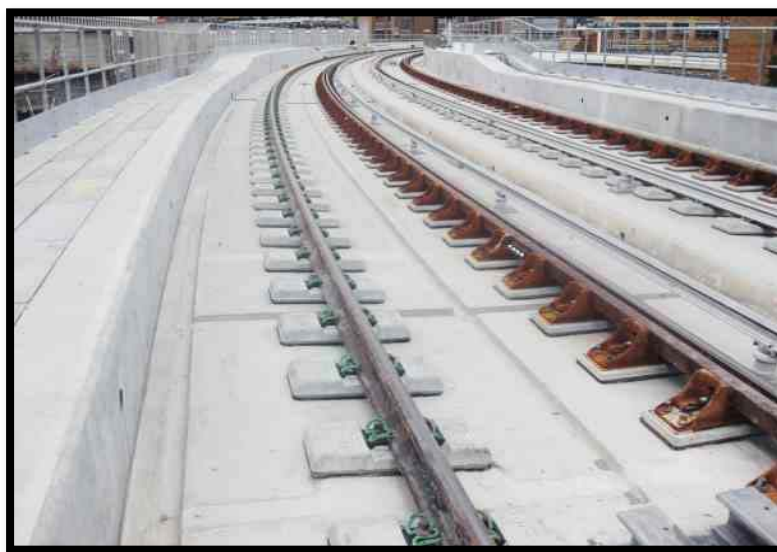
รูปที่ 5-39 ทางรถไฟแบบพื้นคอนกรีตพร้อมหมอนรองรางรถไฟ
