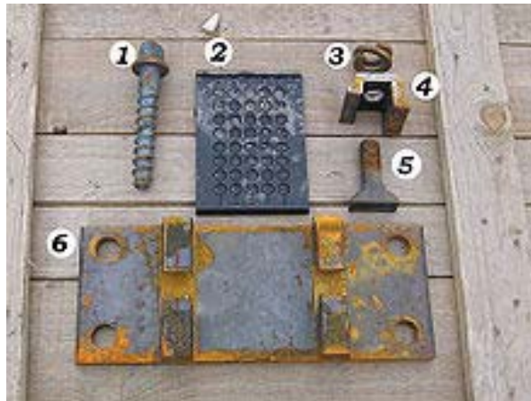
รูปที่ 5-88 ชุดอุปกรณ์เครื่องยึดเหนี่ยวรางบนหมอนไม้ชนิดมีแผ่นเพลต (1.Screw, 2.Elastomeric pad, 3.Tension washer, 4.Rail clamp, 5.Tensioning bolt, 6.Baseplate)
