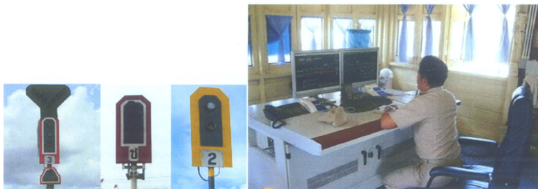
รูปที่ 10.1-2 แสดง สัญญาณไฟสีและแผงควบคุมระบบอัตโนมัติสัญญาณ
