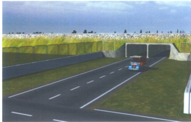
รูปที่ 8-3 ท่อเหลี่ยมลอดใต้ทางรถไฟ (Box Culvert)
