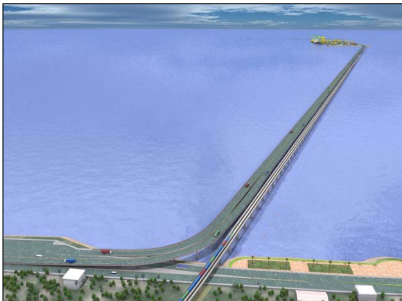
รูปที่ 8.12 ทศนียภาพของสะพานรถไฟในทะเลขนานกับสะพานรถยนต์เข้าท่าเรือน้ำลึกปากบารา
