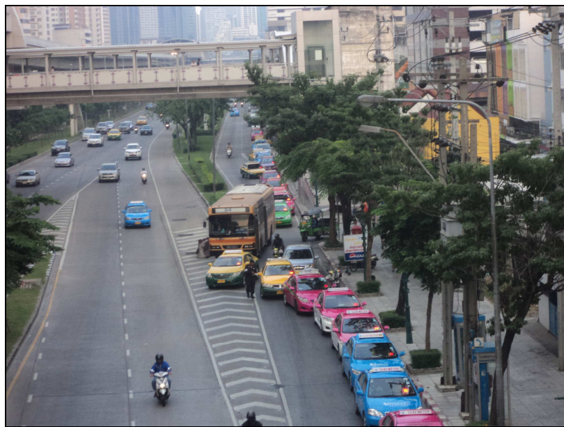
รูปที่ 4.2-3: สภาพกายภาพถนนคู่ขนานทิศมุ่งวงเวียนใหญ่ บริเวณซอยกรุงธนบุรี 4
