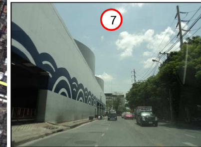
ถนนมิตรไมตรี ทิศมุ่งตะวันตก, 2 ช่องจราจร
