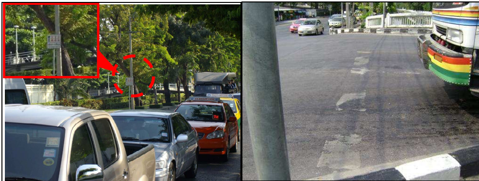
รูปที่ 3.3-15: ป้ายและเครื่องหมายจราจรไม่ชัดเจน
