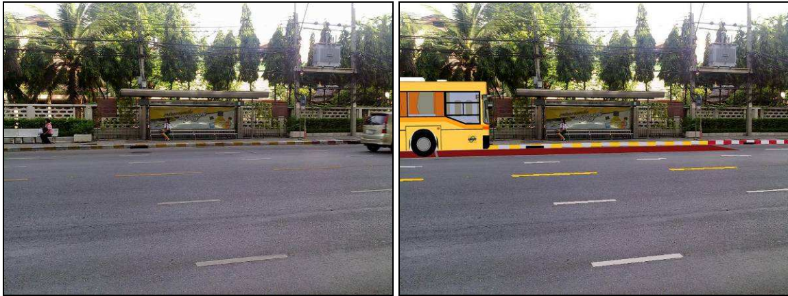
รูปที่ 3.3-26: ทาสีพื้นผิวจราจรบริเวณจุดรับ-ส่ง รถโดยสารประจำทาง (ต่อ)
