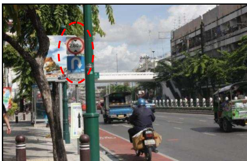
รูปที่ 2.4-9: ตำแหน่งติดตั้งป้ายจำกัดความสูงและขนาดของป้ายไม่เหมาะสม
