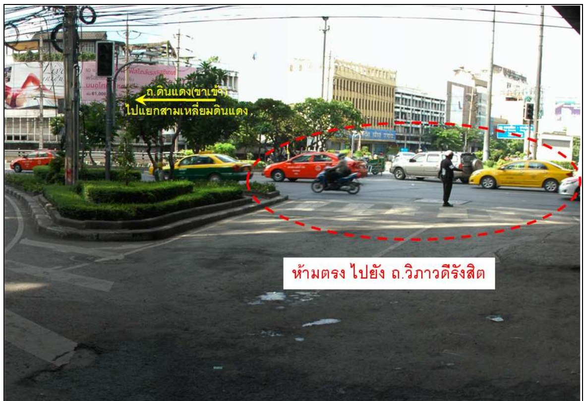
รูปที่ 2.7-15: ถนนใต้ทางด่วนดินแดงขาดอุปกรณ์ควบคุมจราจรบริเวณที่มีการห้าม
