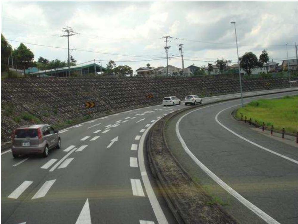
รูปที่ 5.4-1: ตัวอย่างการติดตั้งเครื่องหมายจราจรบนพื้นทาง เพื่อลดปัญหาการเกิดอุบัติเหตุจราจรบริเวณทางโค้งของประเทศญี่ปุ่น
