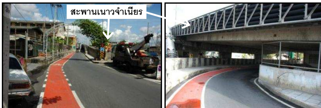
รูปที่ 2.4-7: ที่กัลักรถได้สะพานแนวจำเนียร สำหรับรถขนาดเล็กที่มาจากถนนทอดไท
