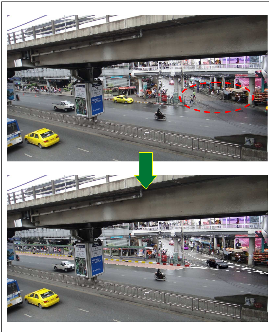
รูปที่ 2.3-30: ปรับปรุงปากซอยแอสปีแลนด์ 2
