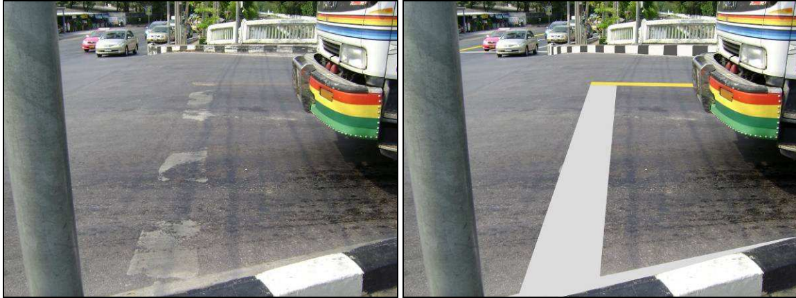
รูปที่ 3.3-36: ทำเครื่องหมายจราจรบนพื้นผิวจราจรให้ชัดเจน
