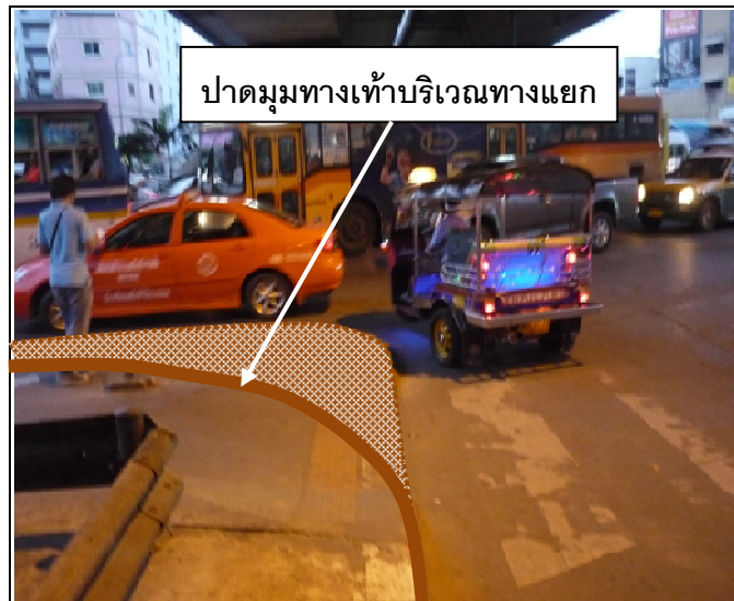
รูปที่ 2.5-24: การปรับปรุงมุมเลี้ยวที่ทางแยกใต้ทางด่วนอนุสาวรีย์ชัยสมรภูมิ (ฝั่งขาเข้า)
