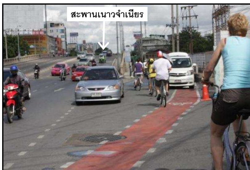
รูปที่ 2.4-8: ช่องจราจรสำหรับเชื่อมเข้ากับกระแสจราจรหลักมีระยะสั้นเกินไป
