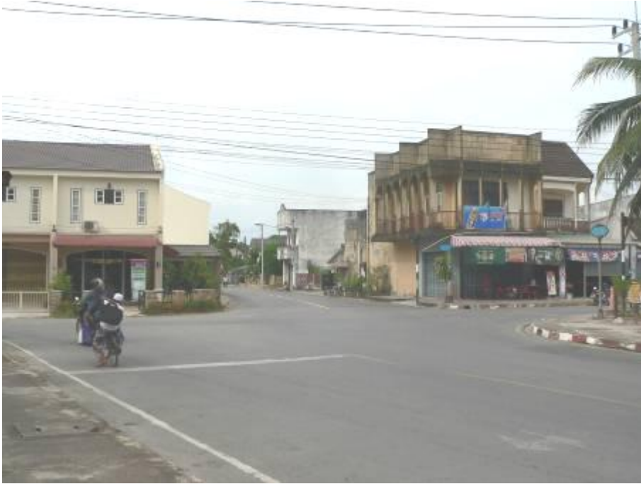
รูปที่ 7.2-3 ลักษณะของทางแยกที่มีสภาพเยื้องกัน
