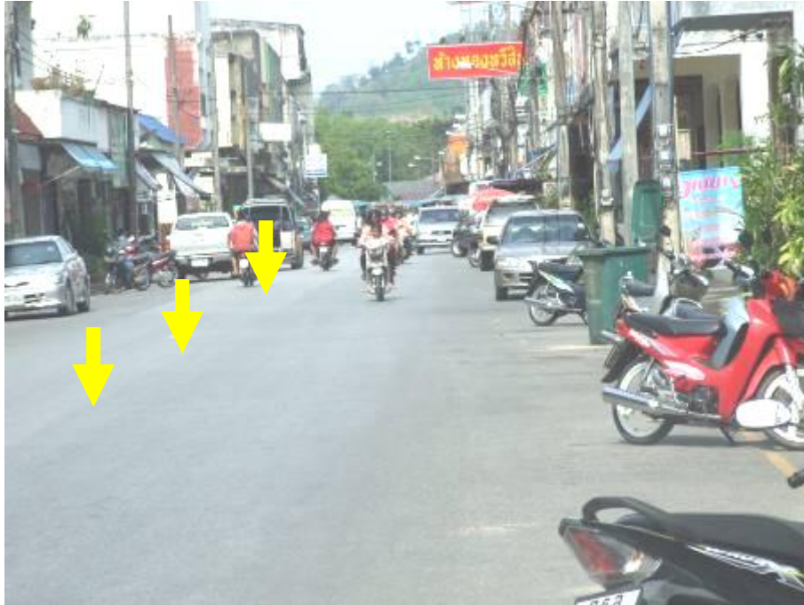
รูปที่ 7.2-6 เส้นจราจรบนผิวทางเลือนลาง
