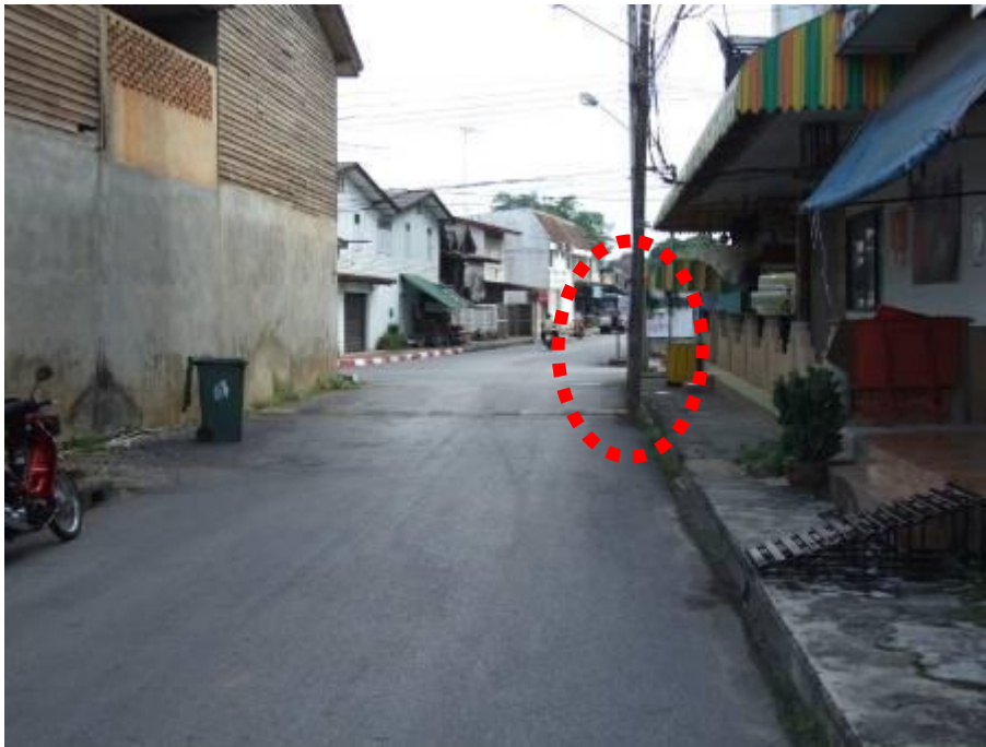
รูปที่ 7.5-11 เนินชะลอความเร็วมีสภาพเลื่องรางและเสาไฟฟ้าอาจเป็นอันตรายต่อผู้ขับขี่
