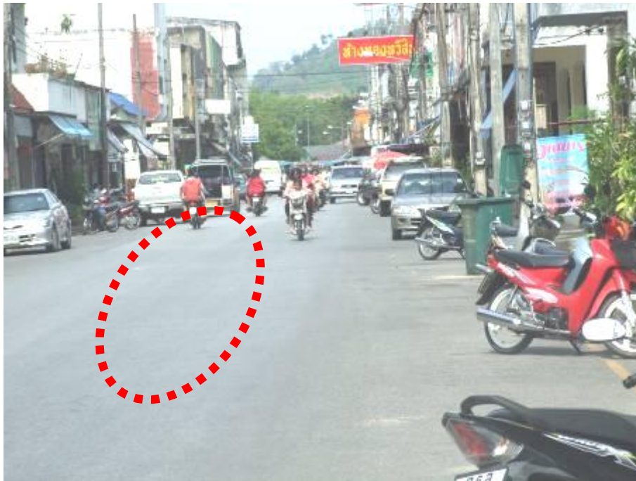
รูปที่ 7.6-1 เส้นจราจรบนผิวทางเลือนราง
