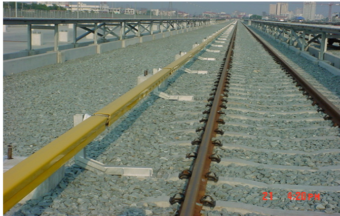
รูปที่ 7.3-3 ทางรถไฟแบบใช้หินโรยทางในบริเวณศูนย์ซ่อมบำรุง
