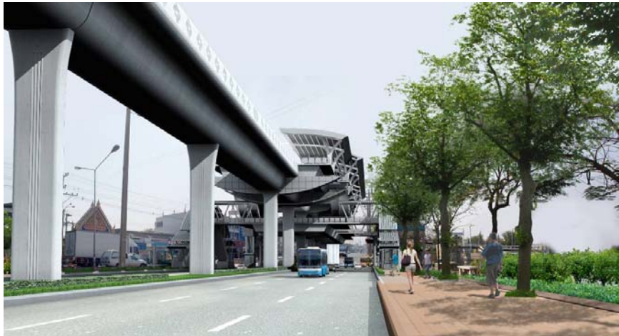
รูปที่ 6.3-11 สภาพพื้นที่หลังการก่อสร้างสถานีศรีจันทร์ : E26
