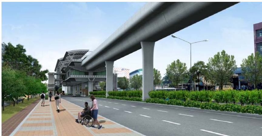
รูปที่ 6.3-10 สภาพพื้นที่หลังการก่อสร้างสถานีเมืองโบราณ : E25
