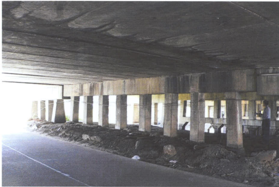
(ก) โครงสร้างพื้นสะพานบริเวณเกาะกลาง
