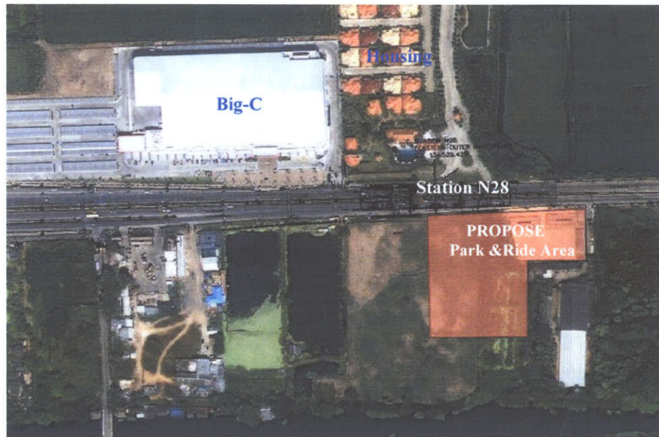
รูปที่ 5.3.1-6 แสดงภาพถ่ายทางอากาศบริเวณที่ตั้งสถานี N28 และที่ตั้งอาคารจอดและจร
