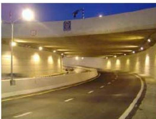
รูปที่ 2.7-6 ระบบไฟฟ้าแสงสว่างภายในทางลอด
