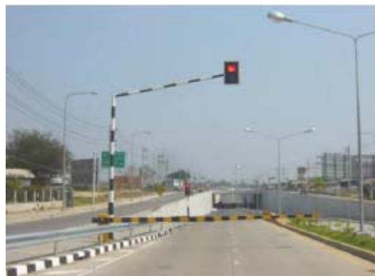
รูปที่ 2.7-5 ระบบแผงกั้นรถยนต์และไฟสัญญาณเตือนอัตโนมัติ
