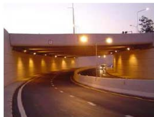
รูปที่ 2.7-6 ระบบไฟฟ้าแสงสว่างภายในทางลอด
