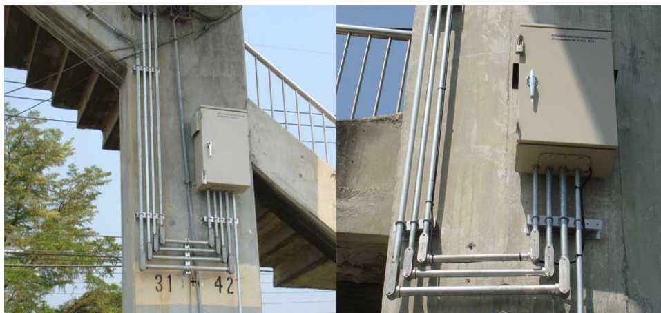
รูปที่ 7.2-3 ภาพตัวอย่างการติดตั้งอุปกรณ์ชุดควบคุมบริเวณเสาของสะพานลอยคนข้ามถนน
