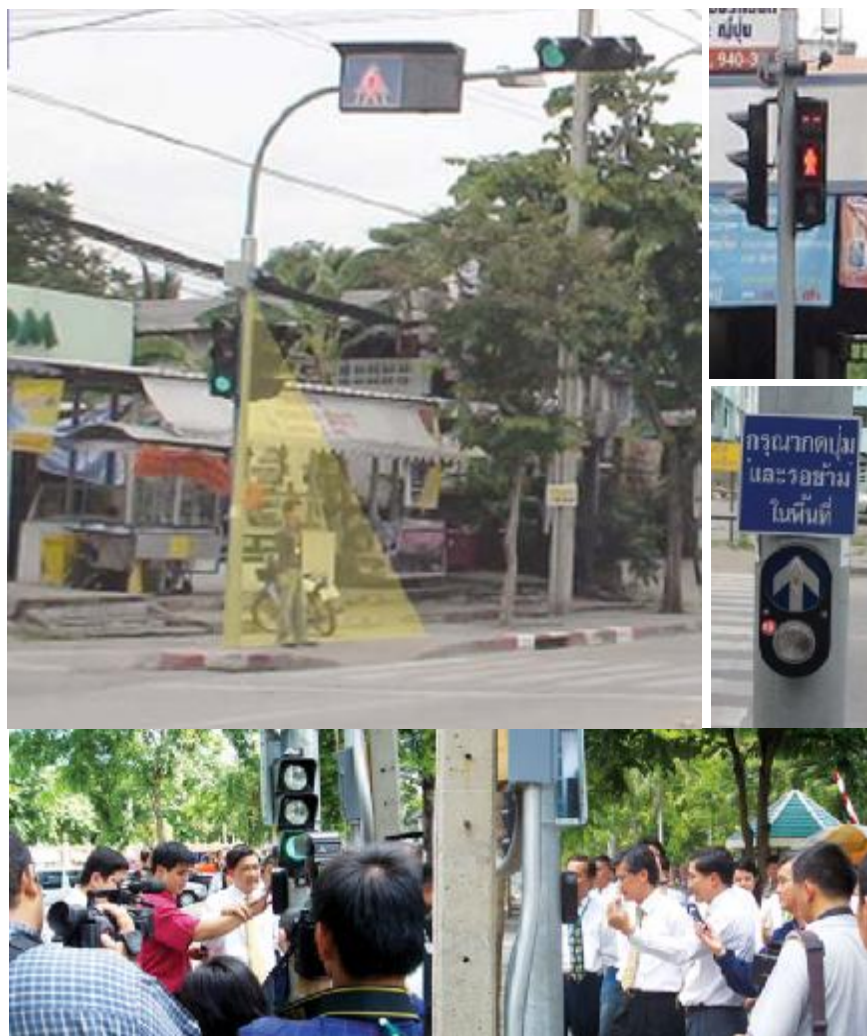
รูปที่ 2.2-2 สัญญาณไฟจราจรคนข้ามถนนอัจฉริยะ
