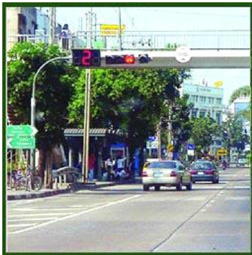
รูปที่ 2.2-1 อุปกรณ์นับเวลาสัญญาณไฟ
