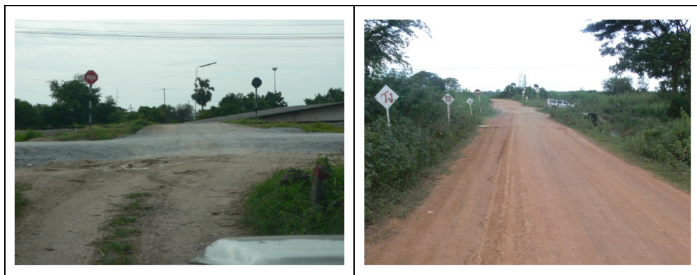
รูปที่ 3.10: แสดงปัญหาไม่มีไฟฟ้าแสงสว่างที่จุดตัดทางรถไฟ
