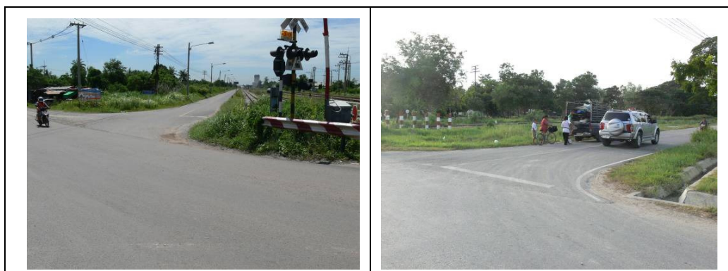
รูปที่ 3.9: แสดงปัญหาถนนขนานทางรถไฟมาตัดทำให้เกิดทางแยกใกล้ทางรถไฟ
