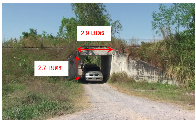
รูปที่ 3.20: ตัวอย่างอุโมงค์ลอดทางรถไฟขนาดเล็ก
