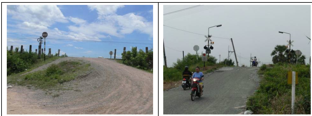
รูปที่ 3.6: แสดงปัญหาถนนช่วงบริเวณจุดตัดทางรถไฟมีความลาดชัน และบางจุดมีความชันหลายระดับ
