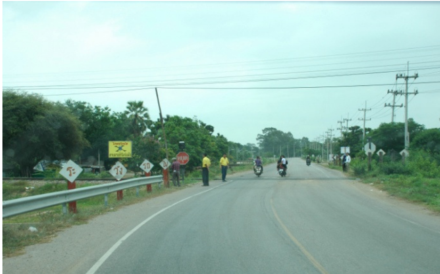
รูปที่ 3.16: สภาพปัจจุบันของจุดตัดทางรถไฟ กม. กม.153+899
