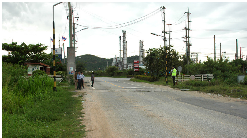
รูปที่ 6.2-14: ลักษณะทางกายภาพก่อนปรับปรุง
