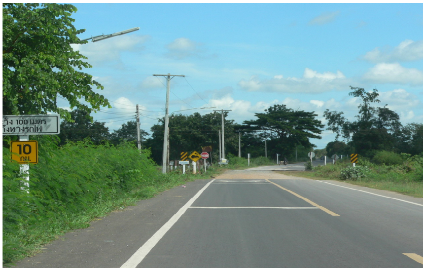
รูปที่ 1.5-1: ตัวอย่างจุดตัดทางรถไฟแบบควบคุมด้วยเครื่องหมายจราจร
