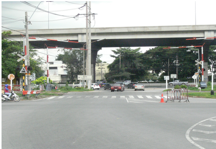
รูปที่ 5.3-2: เครื่องกั้นถนนชนิดคันทำงานด้วยไฟฟ้า (ก.1)
