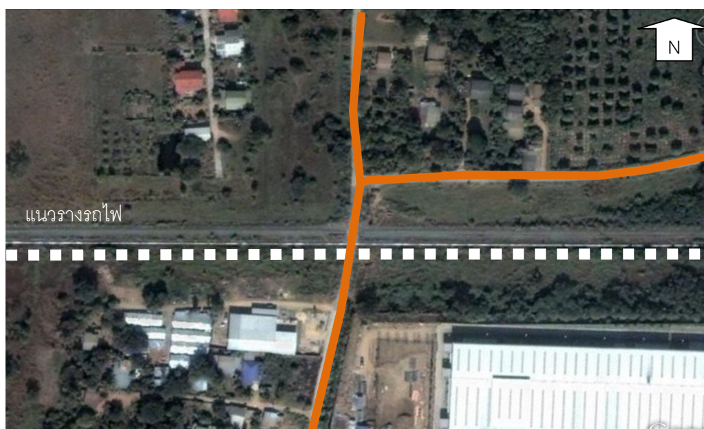
รูปที่ 5.2-16: แสดงตำแหน่งจุดตัดทางรถไฟ กม. 129+839
