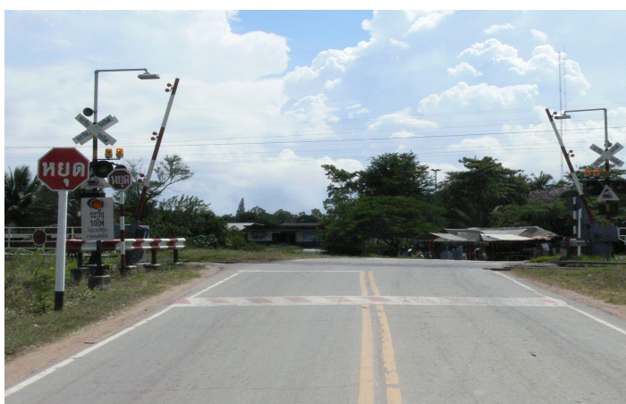
รูปที่ 5.3-6: เครื่องกั้นชนิดคานอัตโนมัติ (ข.1)
