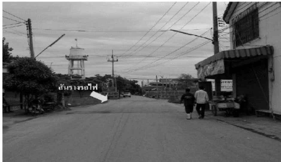
รูปที่ 2.3-1: ภาพถ่ายทางตัดผ่านทางรถไฟกรณีศึกษาที่เกิดอุบัติเหตุหลายครั้ง
