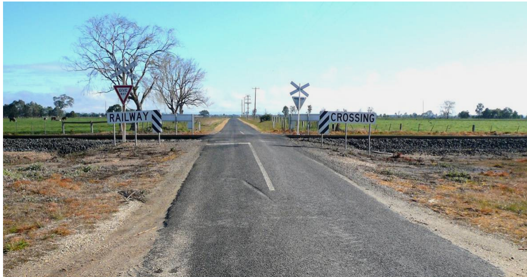
รูปที่ 3.4-6: ป้ายให้ทางที่ใช้ควบคุมบริเวณจุดตัดทางรถไฟ
