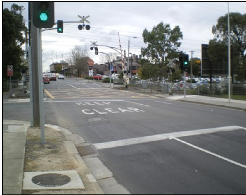
รูปที่ 3.4-12: เครื่องหมายเส้นเหลืองบนผิวทางเพื่อกันรถยนต์จอดคอยใกล้จุดตัดมากเกินไป
