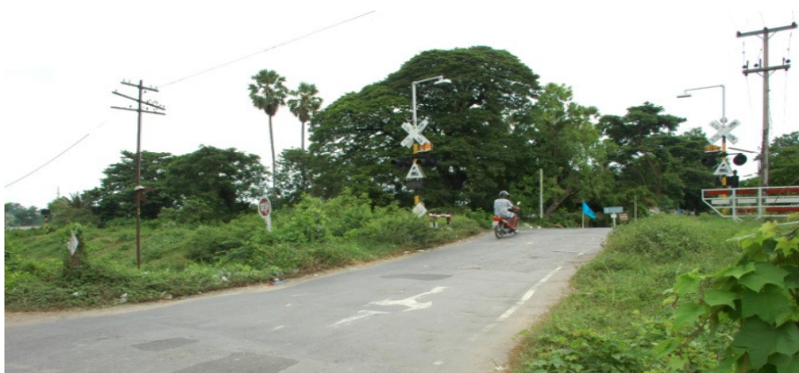
รูปที่ 5.2-44: สภาพปัจจุบันของทางตัดรถไฟ กม. 153+698
