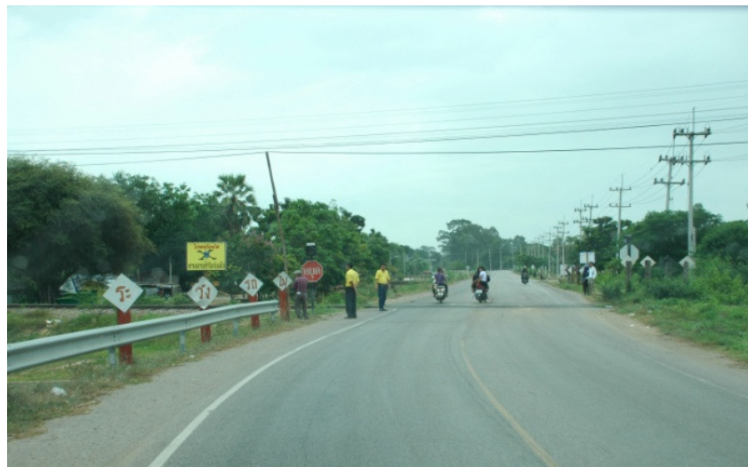
รูปที่ 5.2-50: สภาพปัจจุบันของจุดตัดทางรถไฟ กม.153+899
