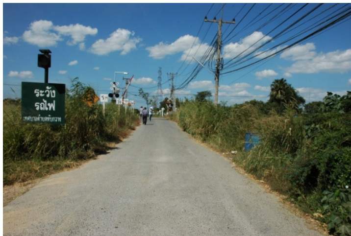
รูปที่ 5.2-17: สภาพปัจจุบันของจุดตัดฯ กม.129+839
