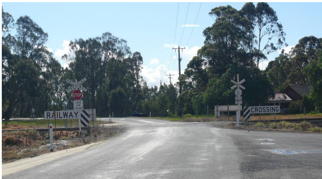
รูปที่ 3.4-7: ป้ายหยุดที่ใช้ควบคุมบริเวณจุดตัดทางรถไฟ
