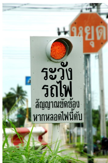
รูปที่ 5.3-9: สัญญาณเตือนระวังรถไฟเครื่องกันถนนขัดข้อง
