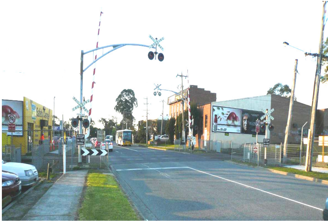
รูปที่ 3.4-11: บริเวณจุดตัดทางรถไฟที่ติดตั้งไฟกะพริบและคานขวางแบบครึ่งถนน รวมทั้งติดตั้งไฟกะพริบและเครื่องหมายรถไฟบนเสาสูงแบบแขนยื่น
