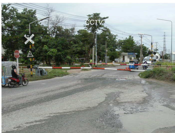
รูปที่ 5.3-1: เครื่องกั้นถนนชนิดคานทำงานด้วยไฟฟ้าควบคุมการทำงานระยะไกล (ก.0) พร้อมระบบโทรทัศน์วงจรปิด (CCTV)
