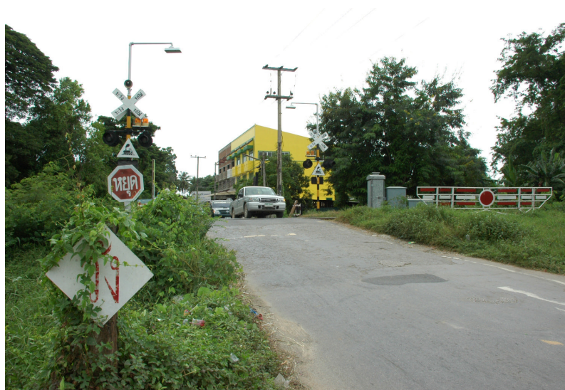
รูปที่ 5.3-7: เครื่องกั้นชนิดไฟวาบอัตโนมัติ (ข.2)
