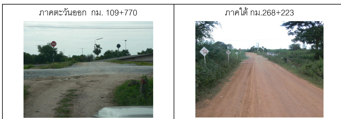
รูปที่ 5.2-6: แสดงปัญหาไม่มีไฟฟ้าแสงสว่างที่จุดตัดทางรถไฟ
