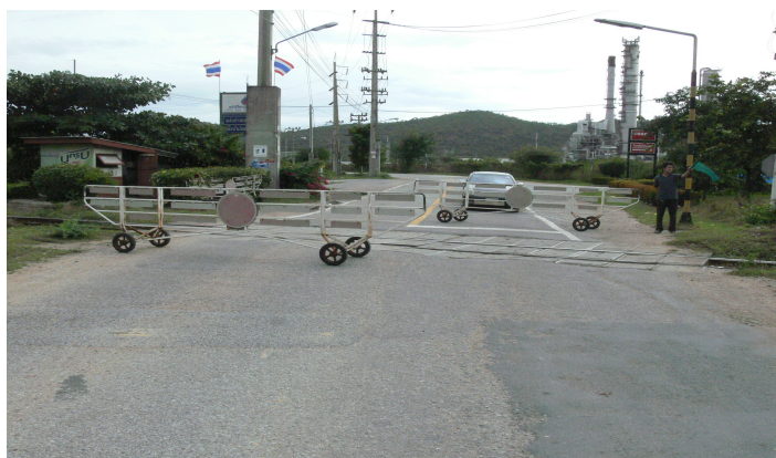
รูปที่ 5.3-5: เครื่องกั้นถนนชนิดแผงเงิน (ก.4)
