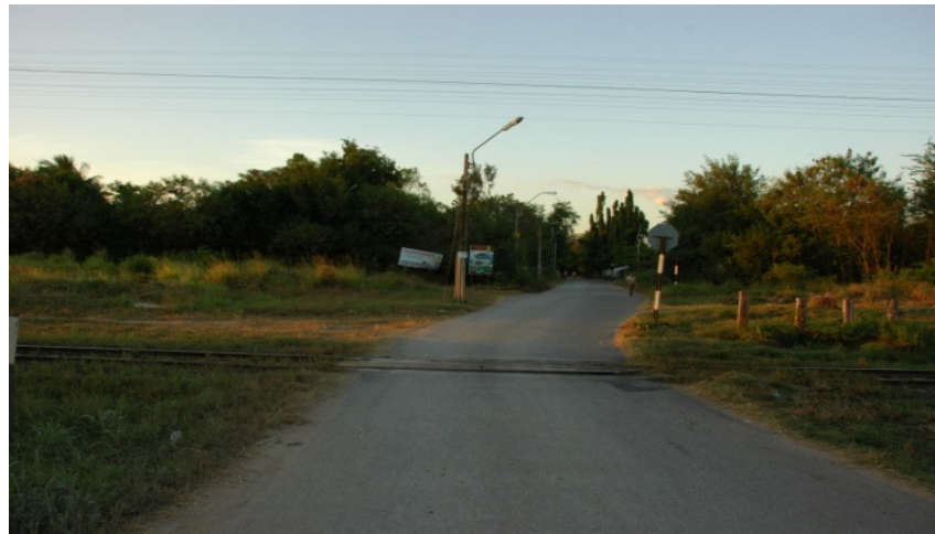
รูปที่ 5.2-23: สภาพปัจจุบันของจุดตัดฯ กม.260+454
