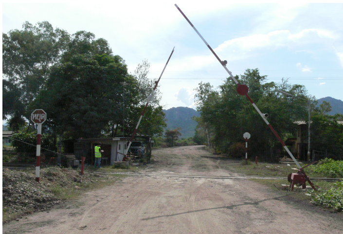
รูปที่ 5.3-3: เครื่องกั้นถนนชนิดคันทำงานด้วยมือหมุน (ก.2)
