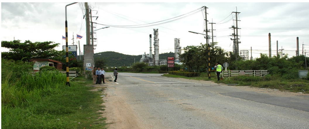
รูปที่ 5.2-35: สภาพปัจจุบันของจุดตัดฯ กม.140+680
