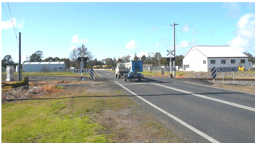
รูปที่ 3.4-10: บริเวณจุดตัดทางรถไฟที่ควบคุมด้วยไฟกะพริบอย่างเดียว
