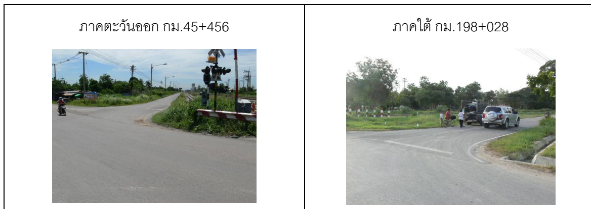
รูปที่ 5.2-5: แสดงปัญหาถนนขนานทางรถไฟมาตัดทำให้เกิดทางแยกใกล้ทางรถไฟ
