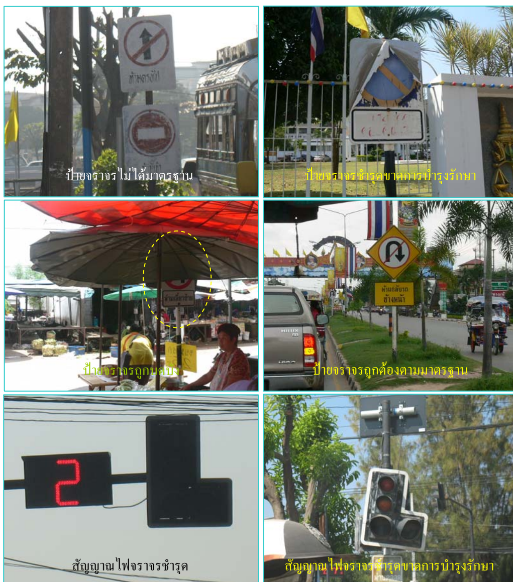
รูปที่ 6.6-1 ปัญหาอุปกรณ์ควบคุมการจราจรไม่ได้มาตรฐาน ขำรุดขาดการบำรุงรักษา
