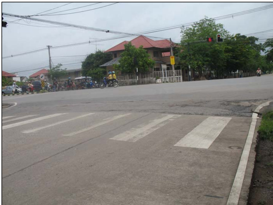
รูปที่ 6.2.4-10 จุดที่ 9 บริเวณสี่แยกข้างโรงเรียนผดุงนารี
