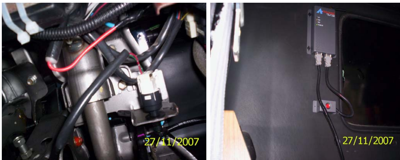
รูปที่ 3.2-6: การติดตั้งอุปกรณ์ติดตามที่รถขนส่งของเสียและกากอุตสาหกรรม (ต่อ)
