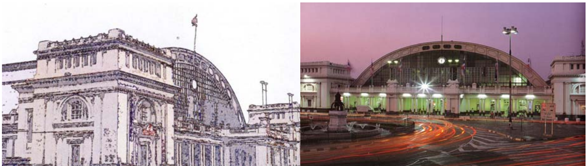
รูปที่ 2.14 สถานีรถไฟกรุงเทพ (สถานีหัวลำโพง)
