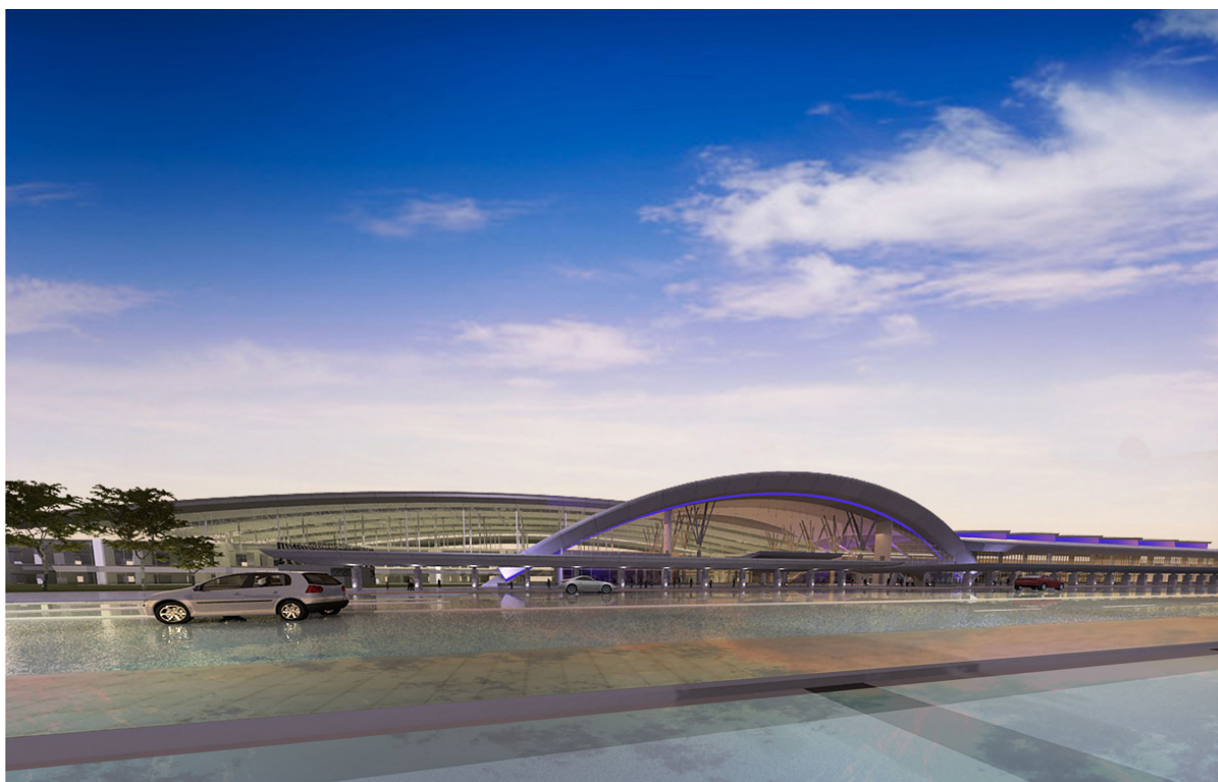
รูปที่ 2.25 ทักษิณภาพภายนอกสถานีกกลางบางซื่อ
