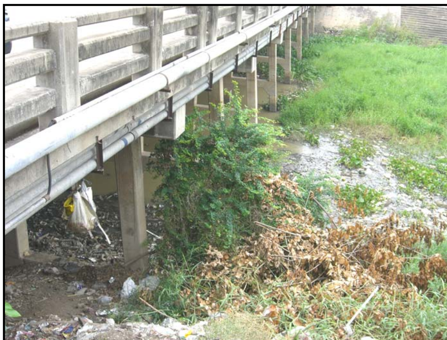
รูปที่ 5.2-6 บริเวณจุดที่ปล่อยน้ำทิ้งลงคลองน้ำซึ่งอยู่บริเวณใต้สะพาน และใกล้บริเวณที่จะมีการดำเนินการก่อสร้างระบบบำบัดน้ำเสียในอนาคต
