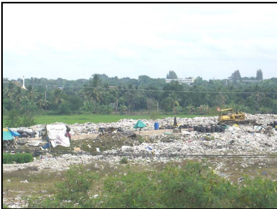
รูปที่ 5.3-3 สถานที่กำจัดขยะในปัจจุบันที่มีการดำเนินการในลักษณะการเทกองบนพื้นที่ เมื่อมีปริมาณมากจึงทำการไถเกลี่ยแล้วกลบทับด้วยดินอีกครั้ง
