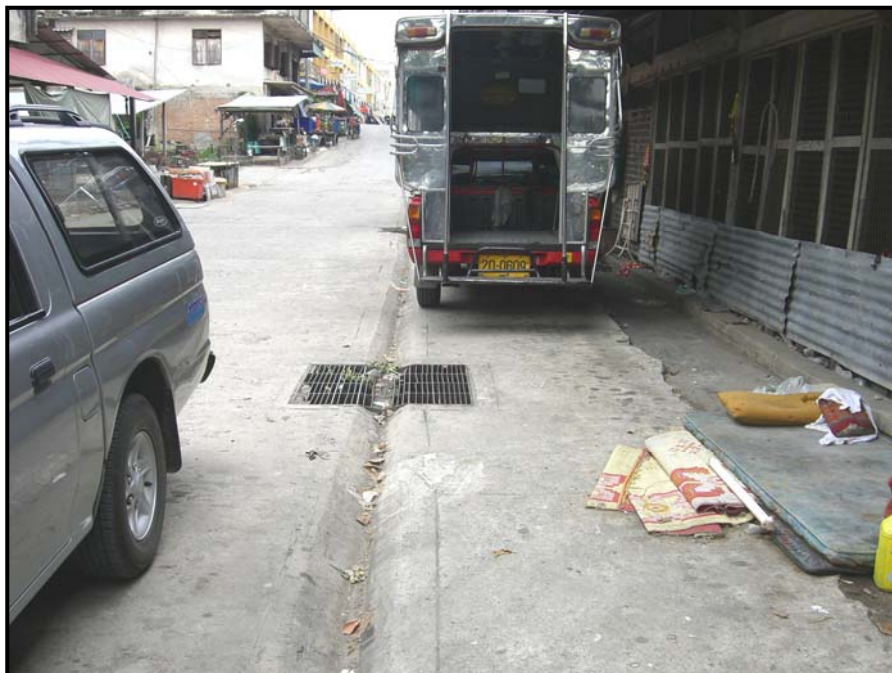
รูปที่ 5.2-1 แนวท่อระบายน้ำทิ้งที่รวบรวมปล่อยลงสู่แม่น้ำลพบุรี
