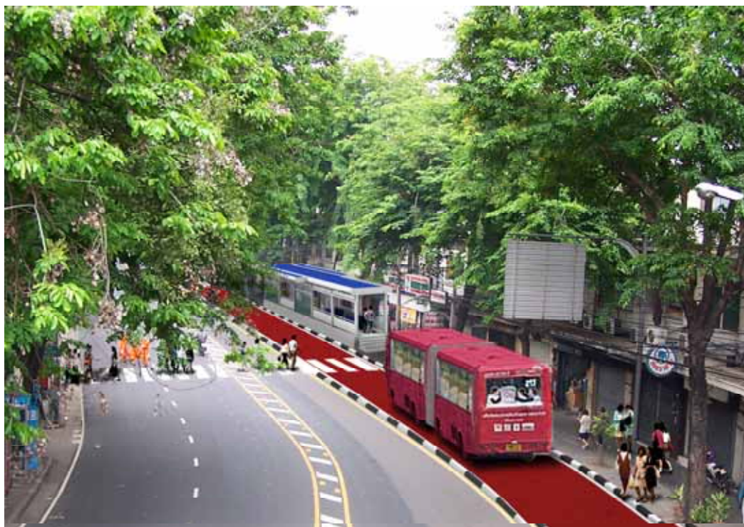
รูปที่ 10 สถานีรถโดยสาร BRT แบบไม่มีสะพานลอย (2)
