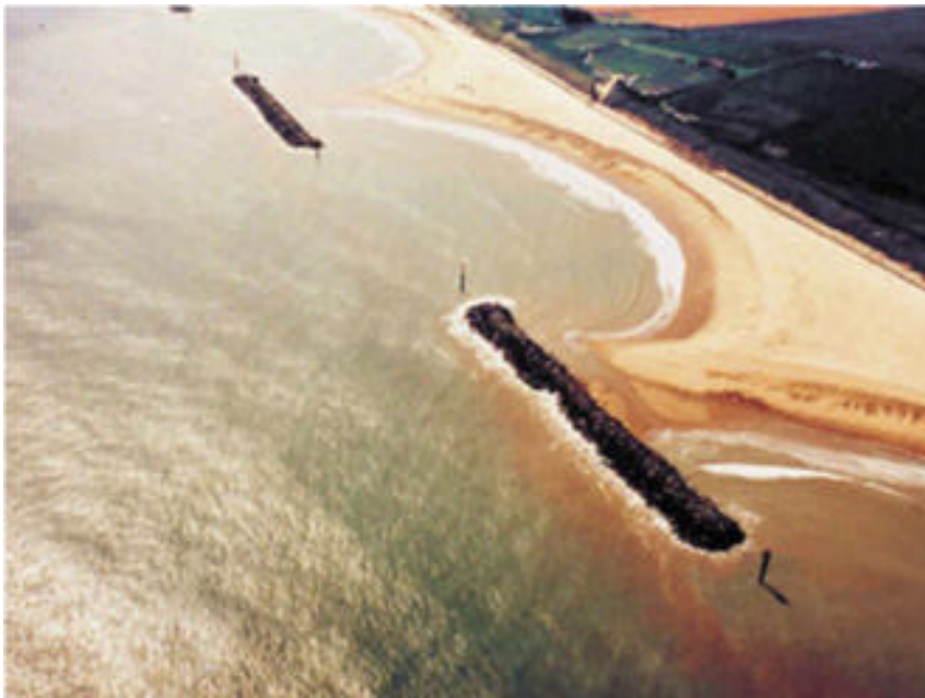
เขื่อนกันคลื่น (Breakwater)
