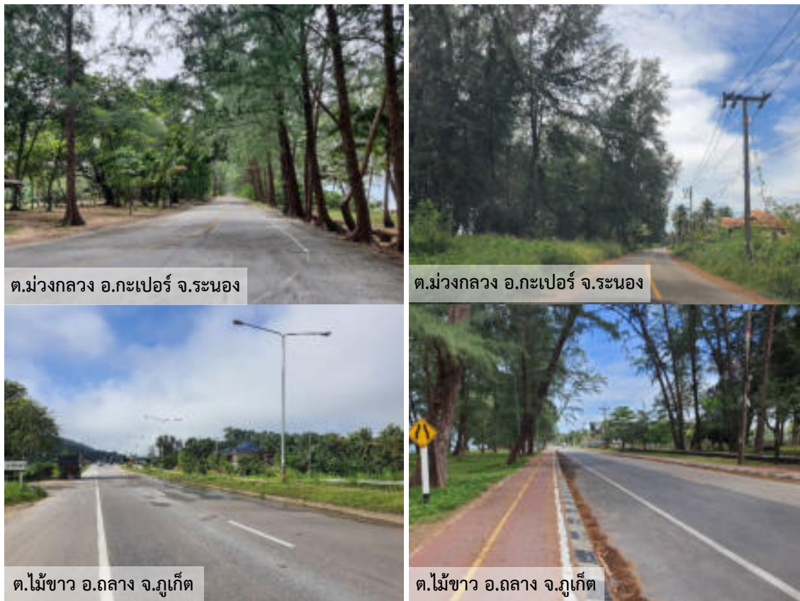
รูปที่ 6.1 - 3 สภาพพื้นที่และลักษณะผิวทางโครงการ
