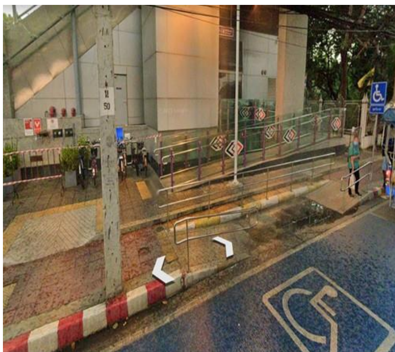
รูปที่ ๔.๘ - ๑ การพัฒนาทางลาดชันบนทางเท้า
