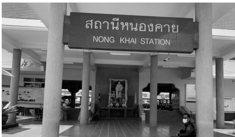
รูปที่ 3.1.3-24 สถานีรถไฟหนองคาย
