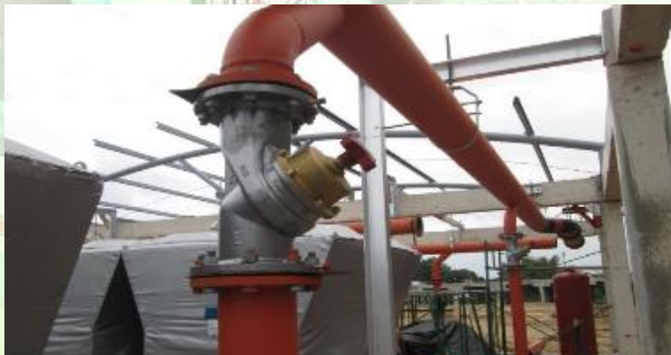
D13 Chiller Plant
