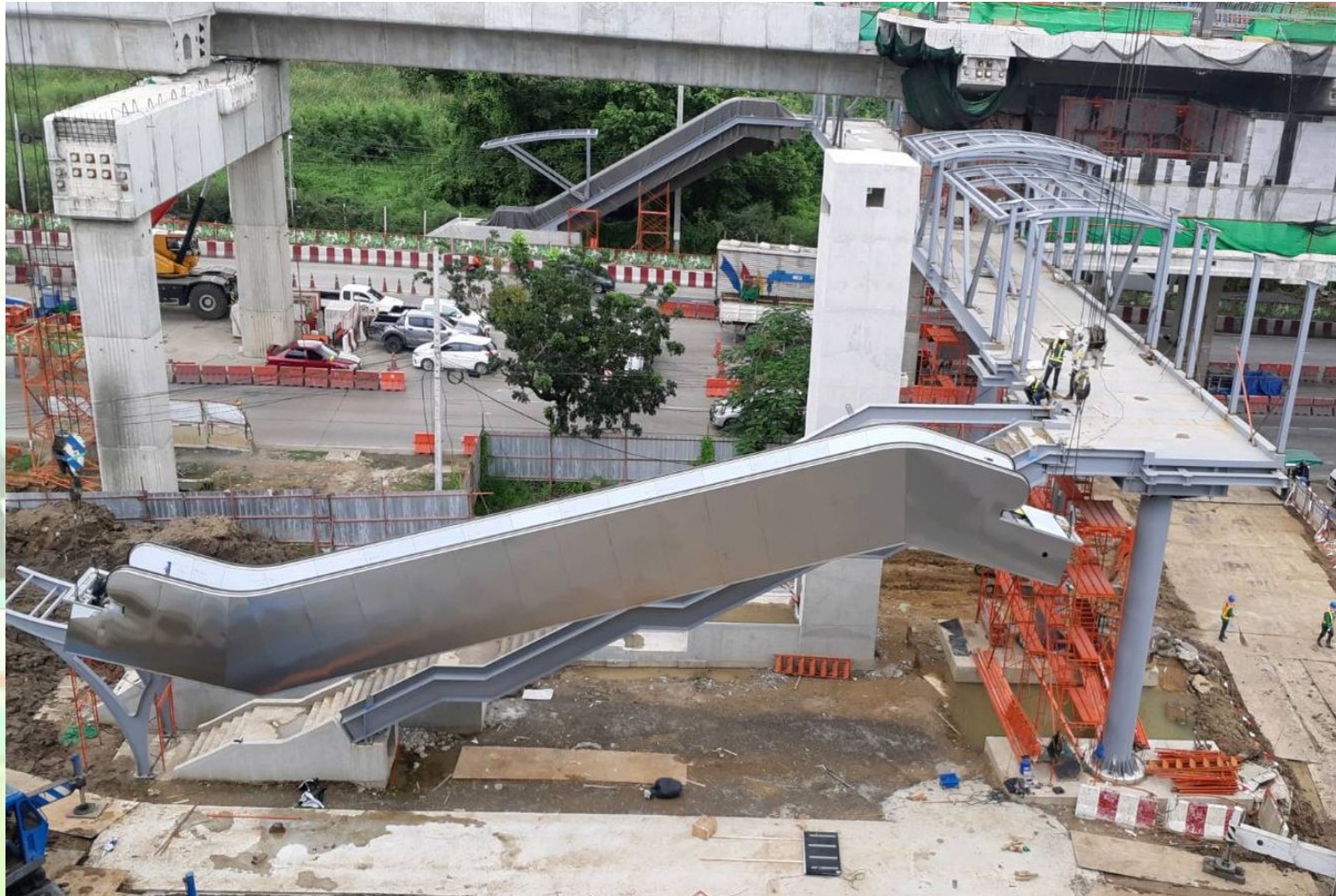
งานติดตั้งบันไดเลื่อน Entrance 24.4 ของสถานีคูคต (Station N24)
