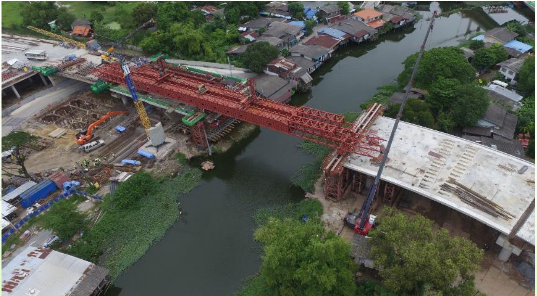
งานก่อสร้าง Special Bridge ภายในศูนย์ซ่อมบำรุง
