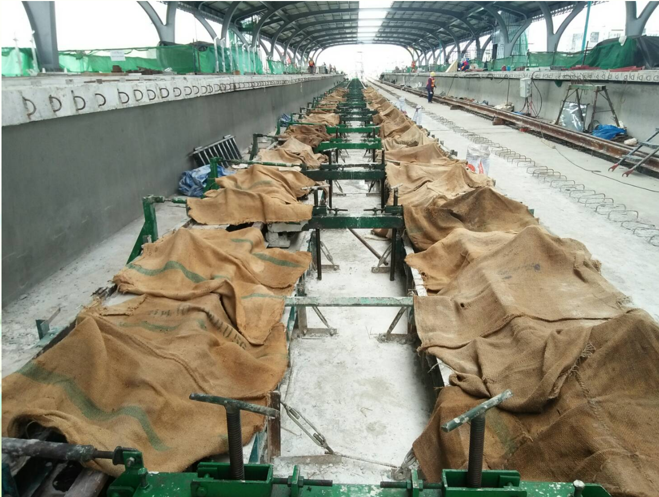
งานก่อสร้าง Track Plinth บริเวณสถานีสายหยุด (N19)
