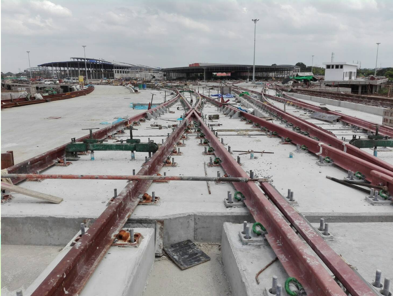
งานติดตั้งประแจ (Turnouts) ภายในศูนย์ซ่อมบำรุง
