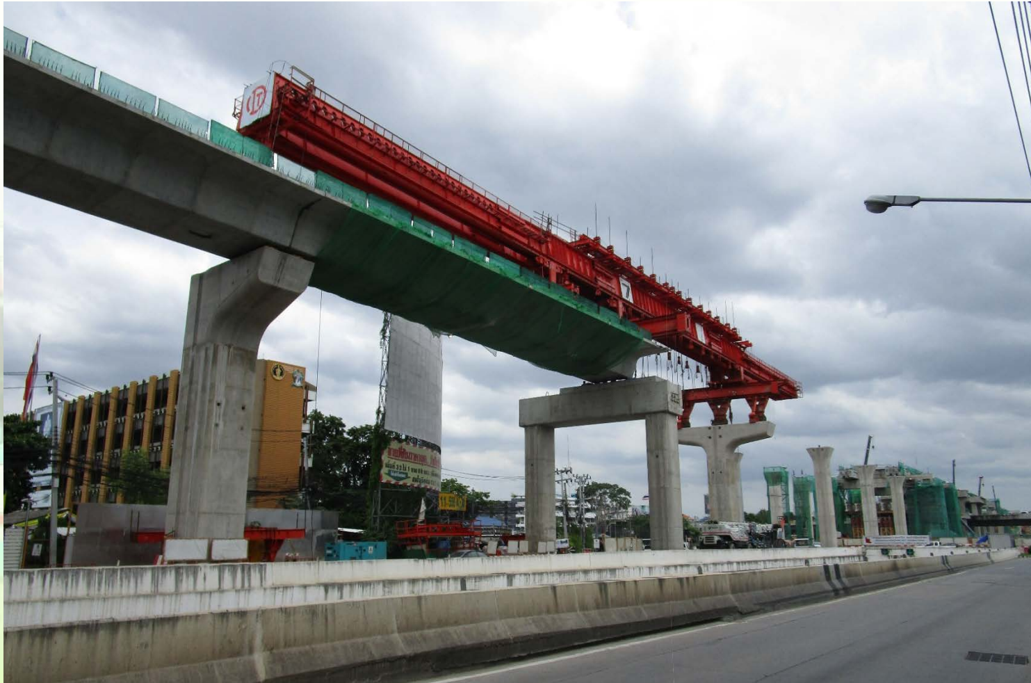
งานติดตั้ง Segmental Viaduct บริเวณวงเวียนหลักสี่
