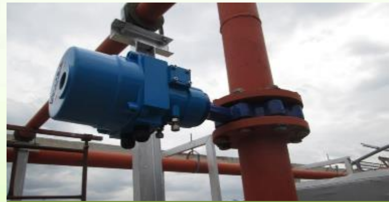
D13 Chiller Plant
