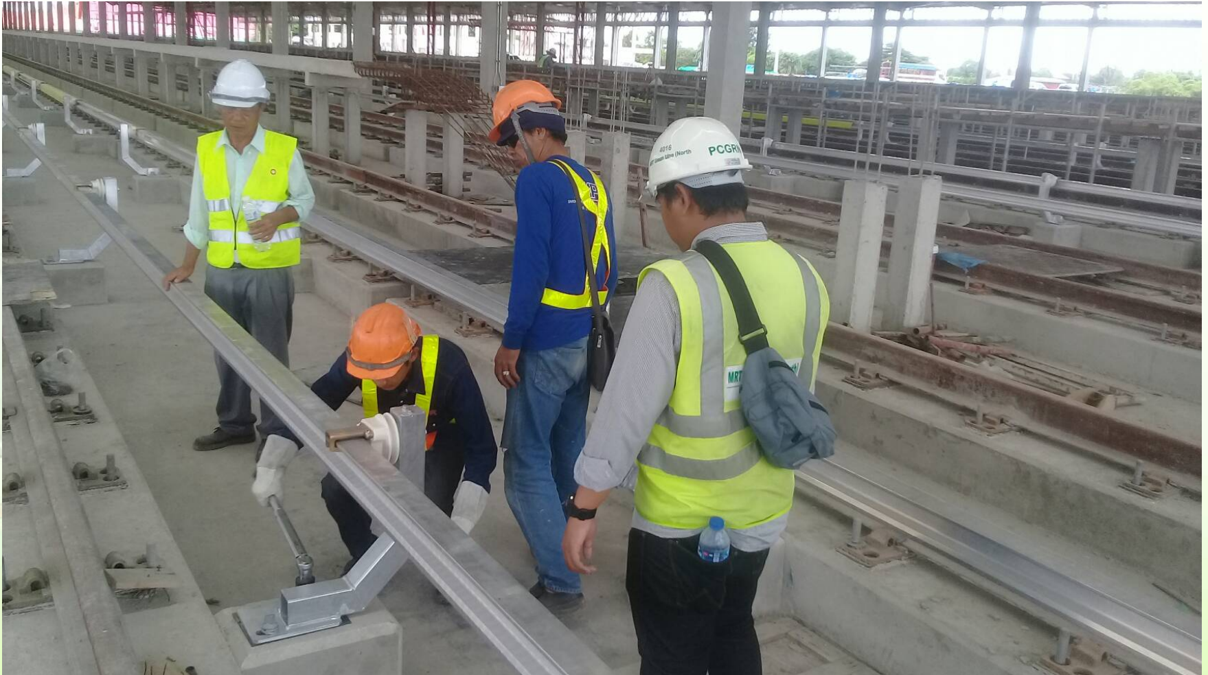
งานติดตั้งรางจ่ายกระแสไฟฟ้า (Conductor Rail) ภายในศูนย์ซ่อมบำรุง
