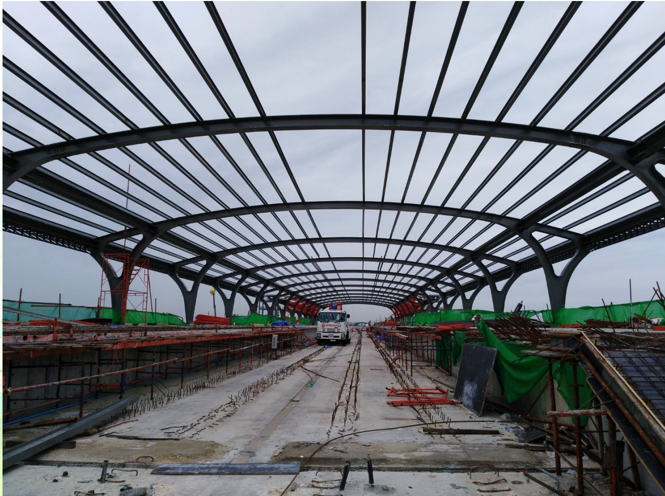
งานก่อสร้างสถานีพิพิธภัณฑ์กองทัพอากาศ (Station N22)
