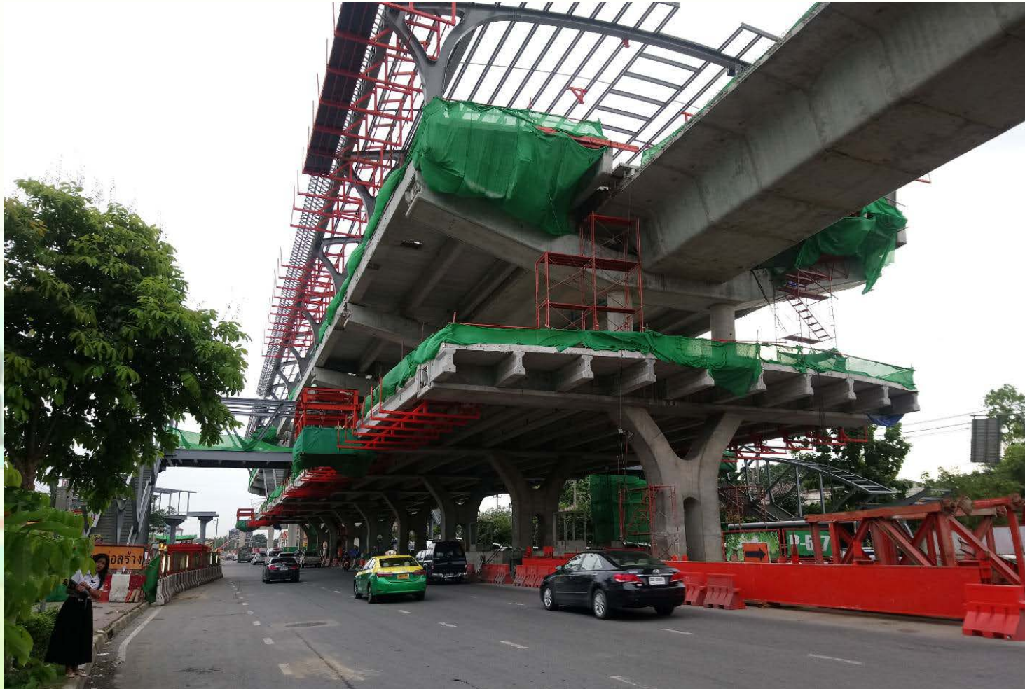
งานก่อสร้างสถานีถ.ม.25 (Station N23)
