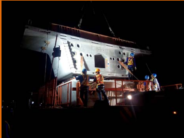
❖ งานยกติดตั้ง Pier Segment (P001)
