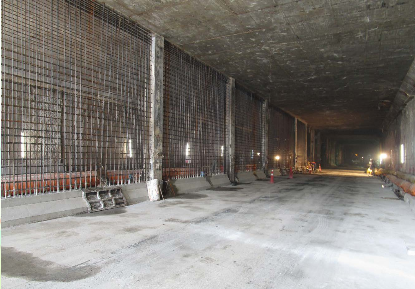
งานผูกเหล็ก Concrete Median Wall ด้านฝั่งศาลาอาญา
