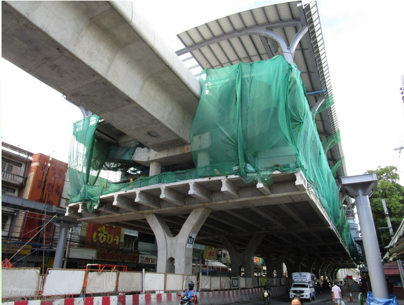
งานก่อสร้างสถานีสะพานใหม่ (Station N20)
