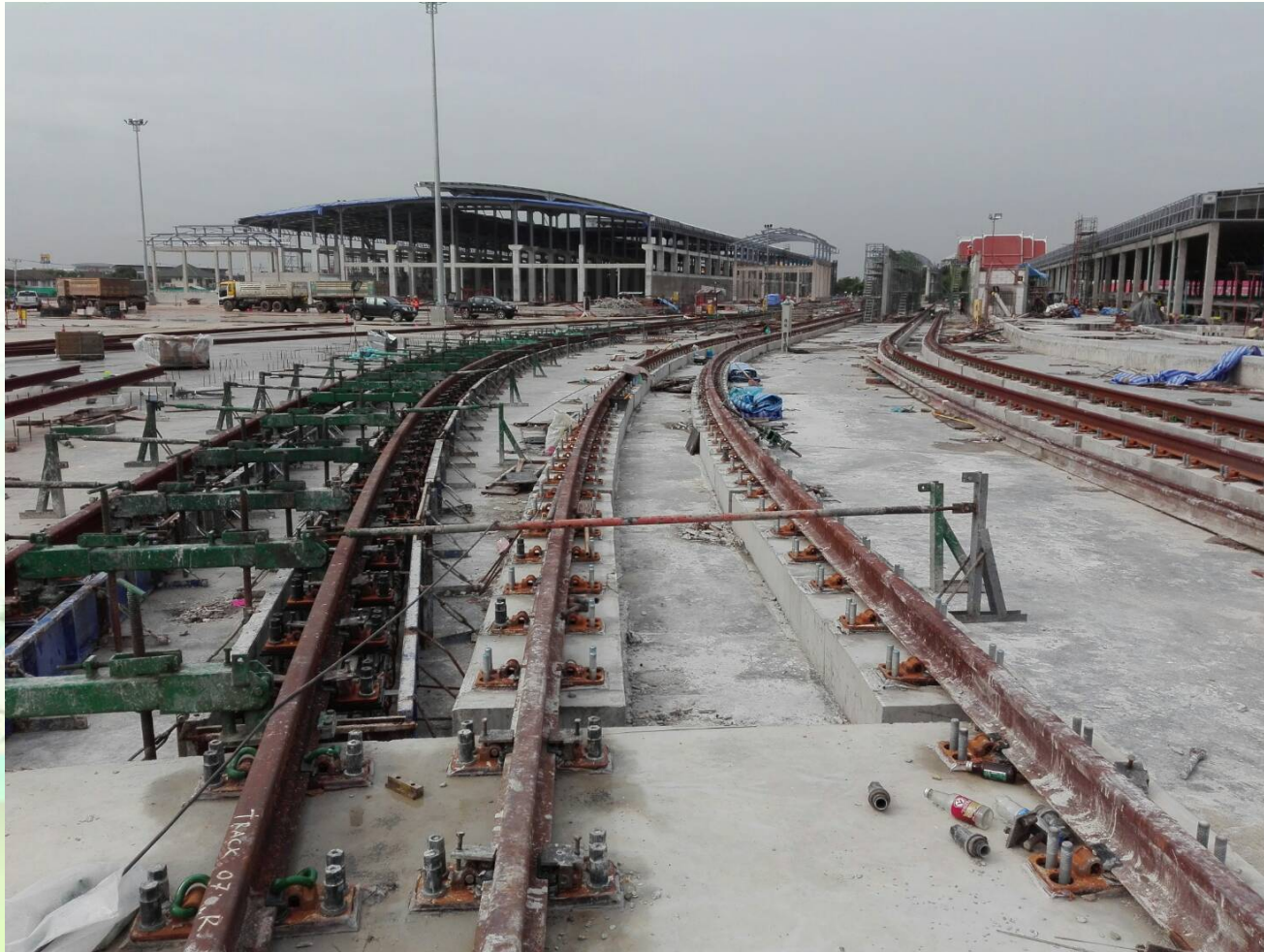
งานก่อสร้าง Track Plinth ภายในศูนย์ซ่อมบำรุง
