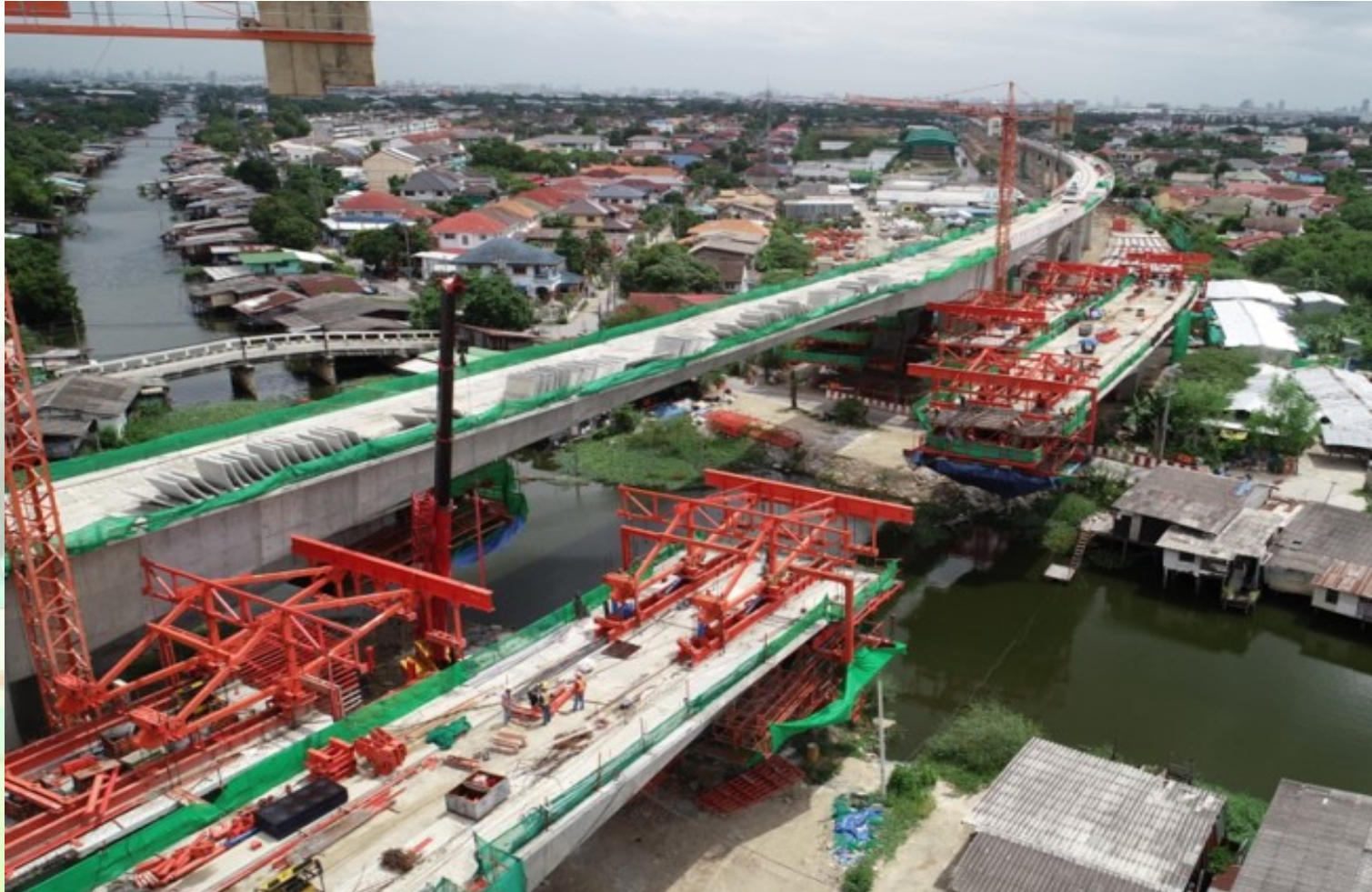
งาน Balanced Cantilever Bridge บริเวณข้ามคลองสอง
