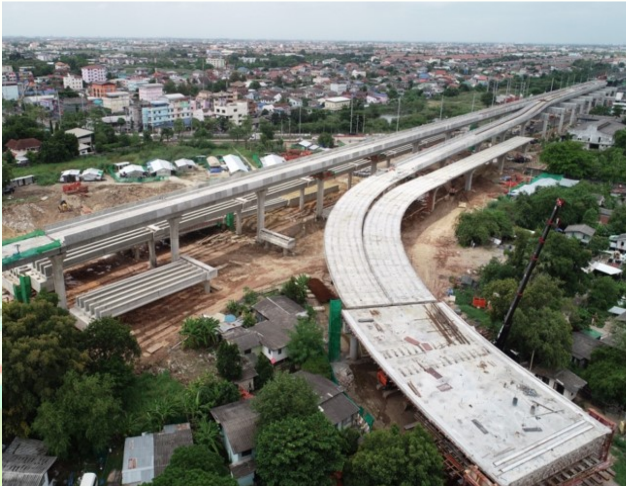
งานติดตั้ง Segmental Viaduct บริเวณ Depot Access and Shunt Track
