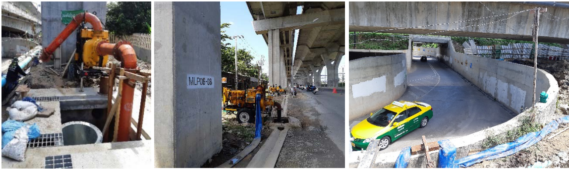
ติดตั้งเครื่องสูบน้ำชั่วคราว
