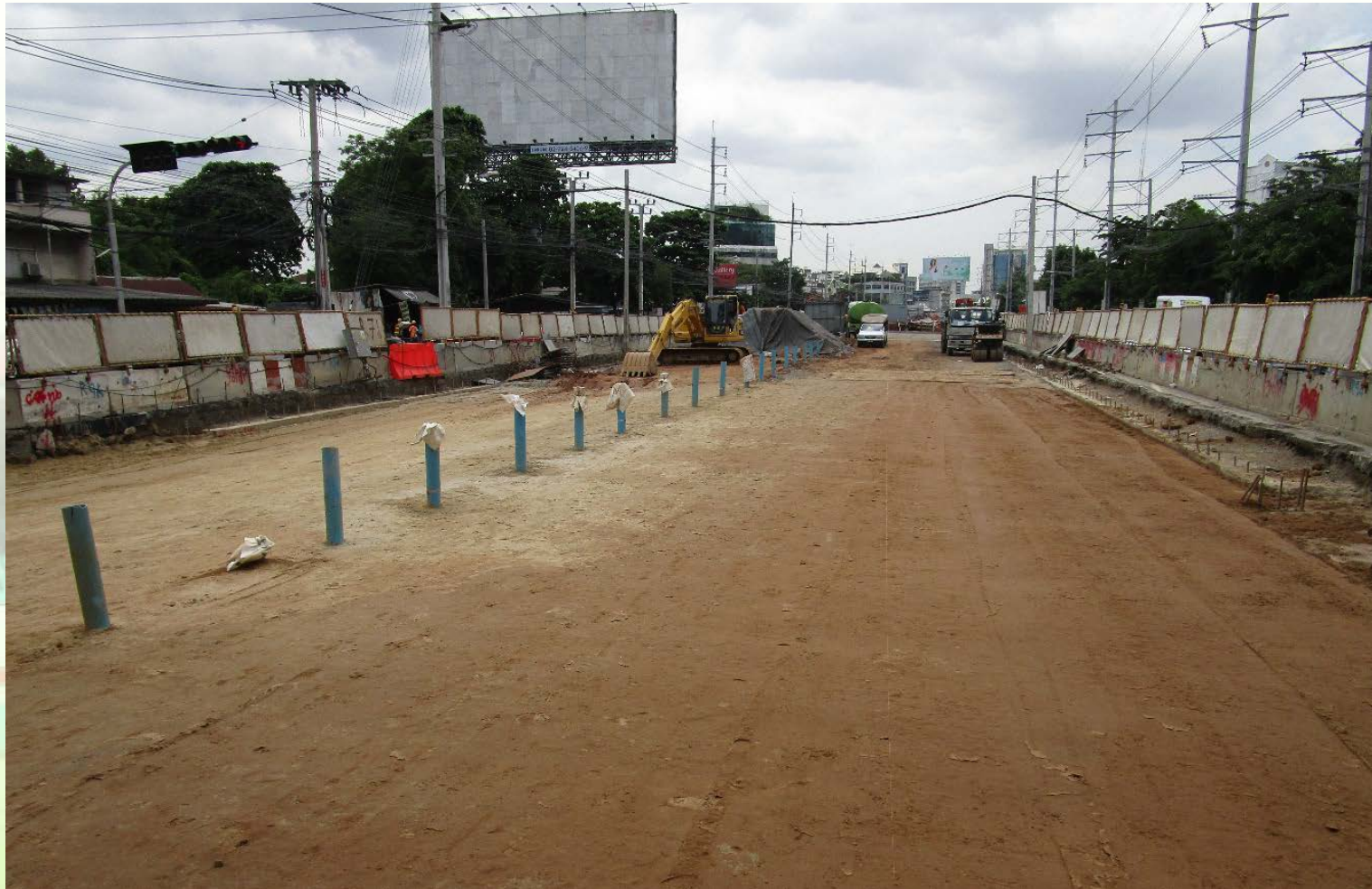
งานถมทรายบน Roof Slab ของอุโมงค์ด้านฝั่งศาลาอาญาฯ
