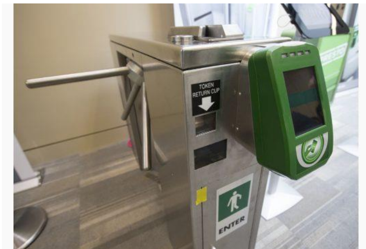
รูปที่ 21 อุปกรณ์ประเมินผลธุรกรรมค่าโดยสารบัตร Presto (Presto fare transaction processor) ติดตั้งด้านหน้าของเครื่องกันทางเข้าสถานีรถไฟฟ้าใต้ดินที่ใช้อยู่ในปัจจุบัน
