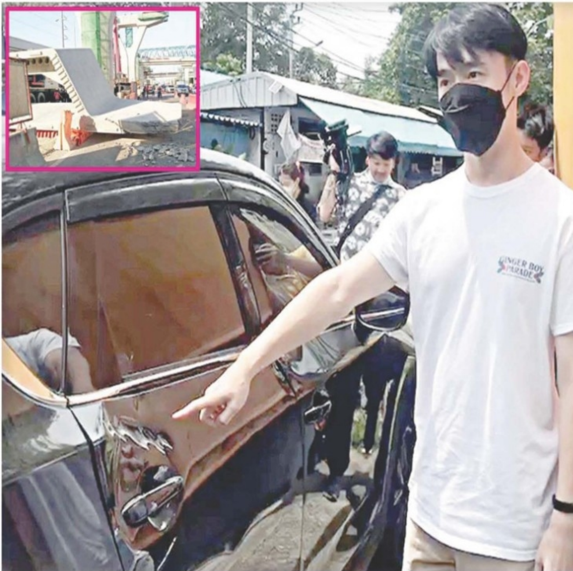
▲เหยื่อถล่ม...นายชัยรัฐ ศรีวิชัยพงษ์ เจ้าของรถยนต์มาสด้าซีเอ็กซ์ 5 สีเทา ชี้นำดูรอยเศษปูนจากคานปูนขนาดใหญ่ใช้ก่อสร้างทางด่วนโครงการทางด่วนพระราม 3-บ้านแพ้ว (ภาพเล็ก) ถล่มลงมากระเด็นใส่เสียหายน
