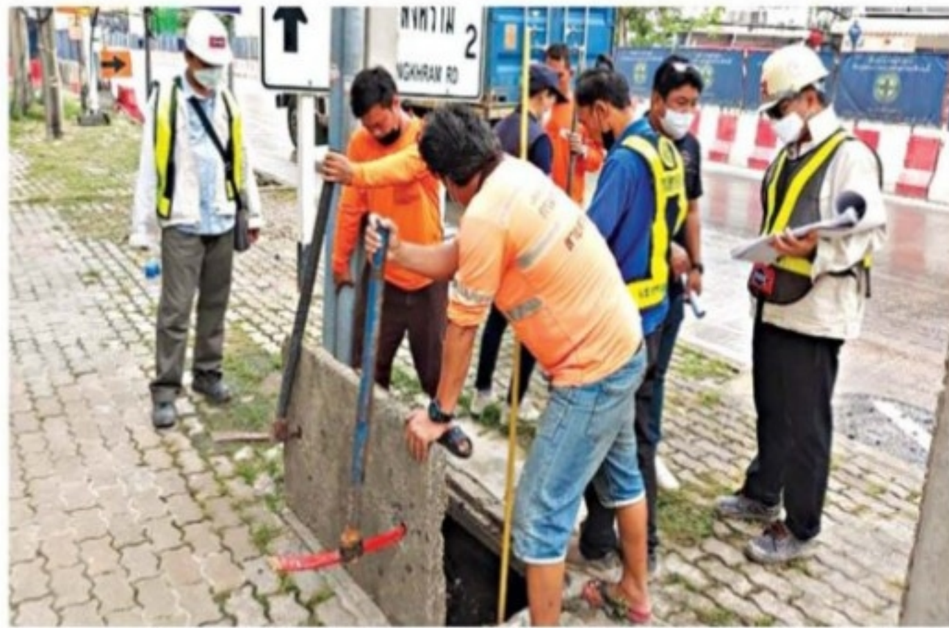
ลอกท่อ... การรถไฟฟ้าขนส่งมวลชนแห่งประเทศไทย (รฟม.) ในฐานะหน่วยงานกำกับโครงการรถไฟฟ้าสายสีชมพูช่วงแคราย-มีนบุรี พร้อมแขวงทางหลวงชนบทบุรี ลอกท่อถนนติวานนท์แนวก่อสร้างโครงการฯเพิ่มประสิทธิภาพการระบายน้ำรวมทั้งติดตั้งเครื่องสูบน้ำถนนรามอินทราซอย 5 จุดเสี่ยงน้ำท่วม
