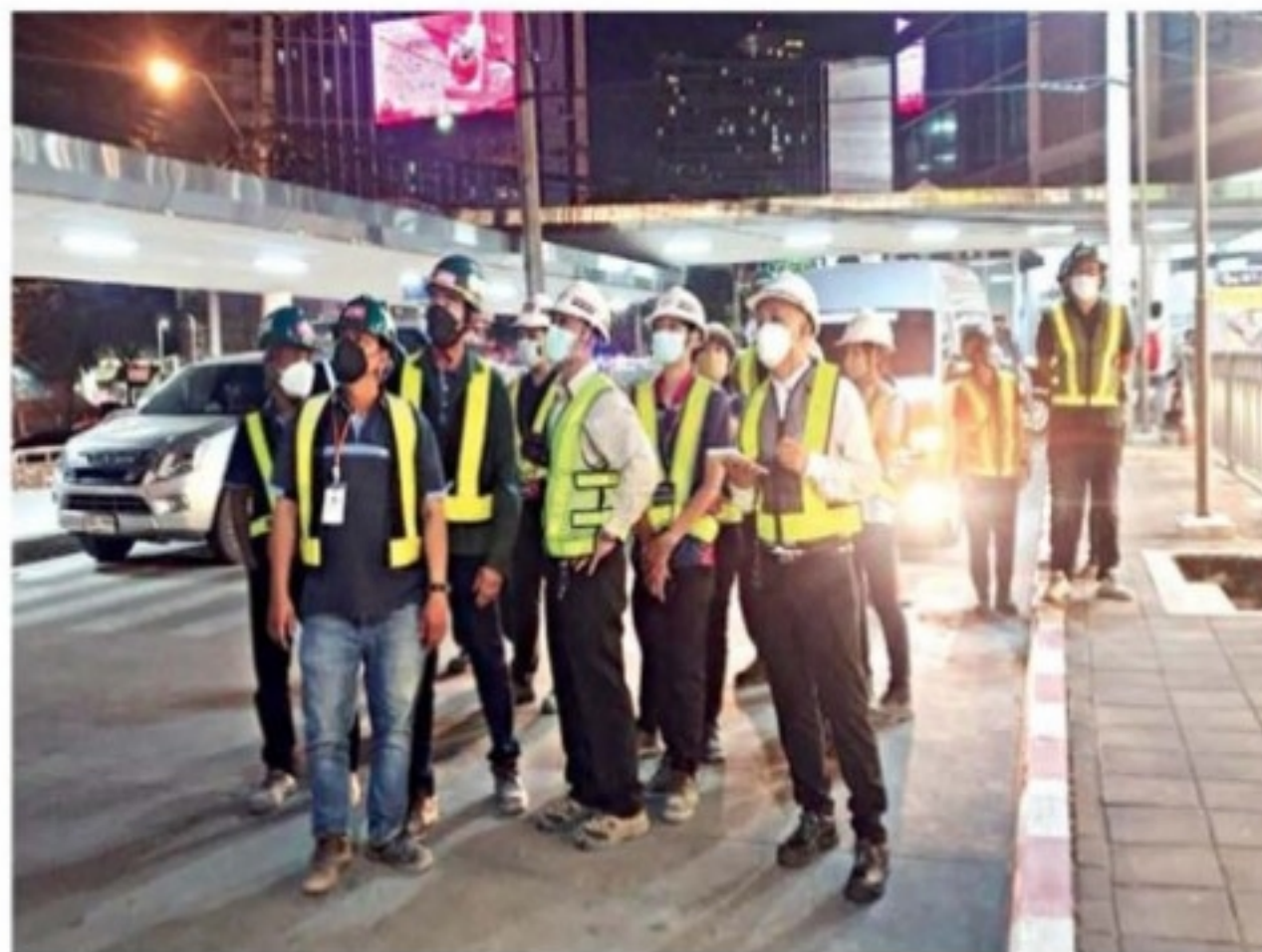
ตรวจงาน... สำนักงานความปลอดภัยอาชีวอนามัยและสภาพแวดล้อมในการทำงาน (สปอ.) การรถไฟฟ้าขนส่งมวลชนแห่งประเทศไทย (รฟม.) ตรวจสอบความปลอดภัยการก่อสร้างโครงการรถไฟฟ้าสายสีเหลืองช่วงลาดพร้าว-สำโรง เวลาากลางคืนบริเวณสถานีลาดพร้าวและตลอดแนวก่อสร้างถนนลาดพร้าว
