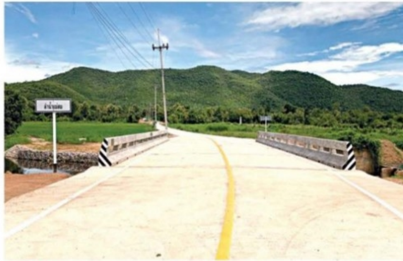
สะพานใหม่... แขวงทางหลวงชนบทลำพูน กรมทางหลวงชนบท (ทช.) เปิดใช้สะพานข้ามลำน้ำแม่สม ต.ศรีบัวบาน อ.เมืองลำพูน จ.ลำพูน ยาว 20 เมตร กว้าง 9 เมตร พร้อมถนนคอนกรีตเสริมเหล็ก ยาว 450 เมตร 2 ช่องจราจร รวมระยะทาง 470 เมตร อำนวยความสะดวกประชาชนแล้ว
