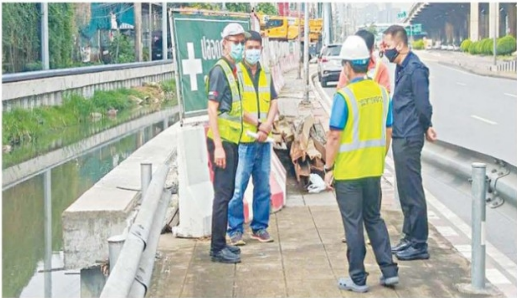
ตรวจงาน...ดร.มนตรี เดชาสกุลสม ผู้อำนวยการสำนักงานทางหลวงที่ 13 กรมทางหลวง นำผู้เกี่ยวข้องตรวจติดตามโครงการพัฒนาคูน้ำริมถนนวิภาวดีรังสิต ระยะที่ 2 ตอน 1 บริเวณ ถนนวิภาวดีรังสิต ทล.31 ช่วง กม.5+500 – กม. 10+700 (RT.) ตามแผนพัฒนาจัดการป้องกัน และแก้ไขปัญหาน้ำท่วมขังบนถนนวิภาวดีรังสิตอย่างยั่งยืน
