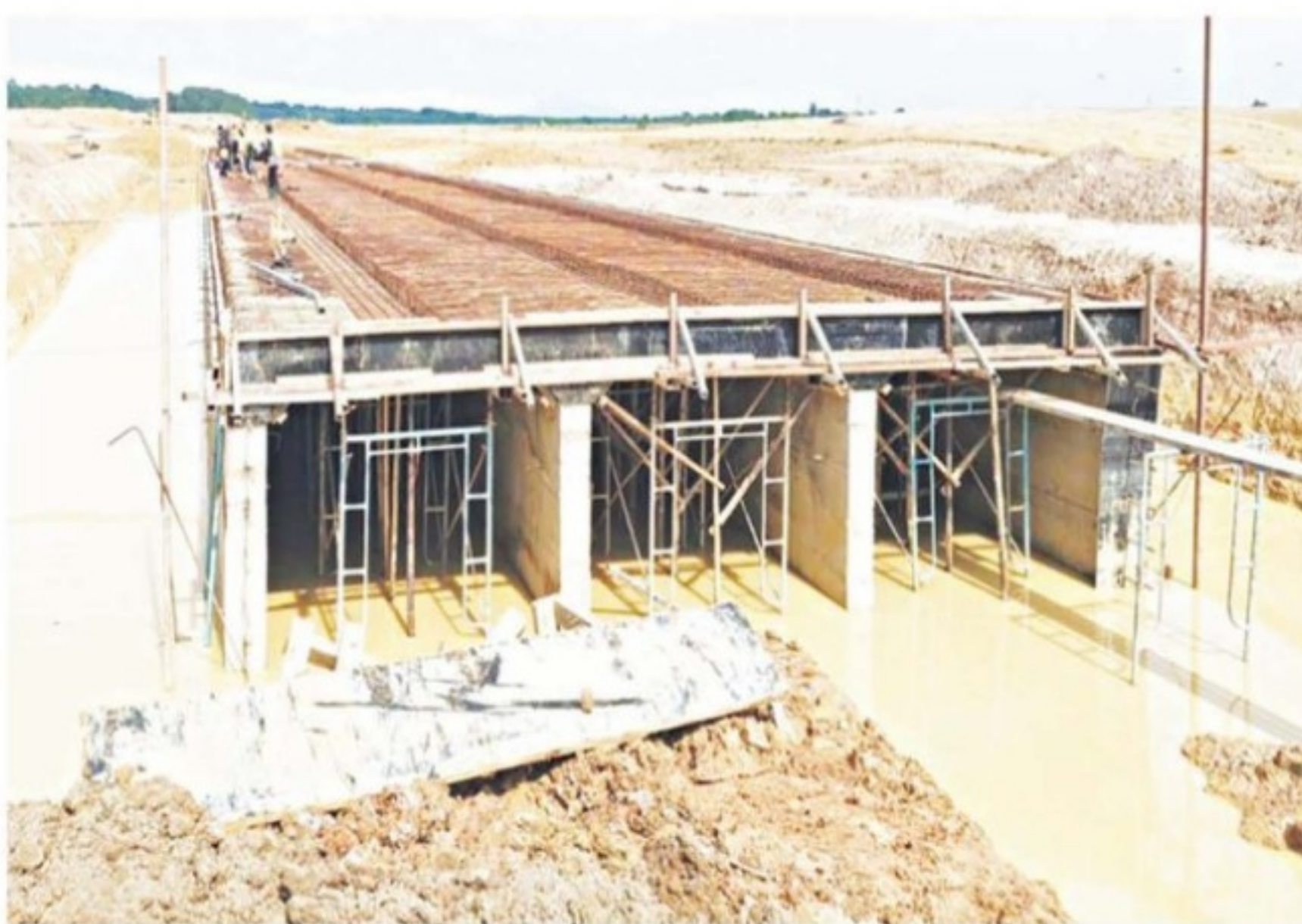
งานลานจอดตรัง
