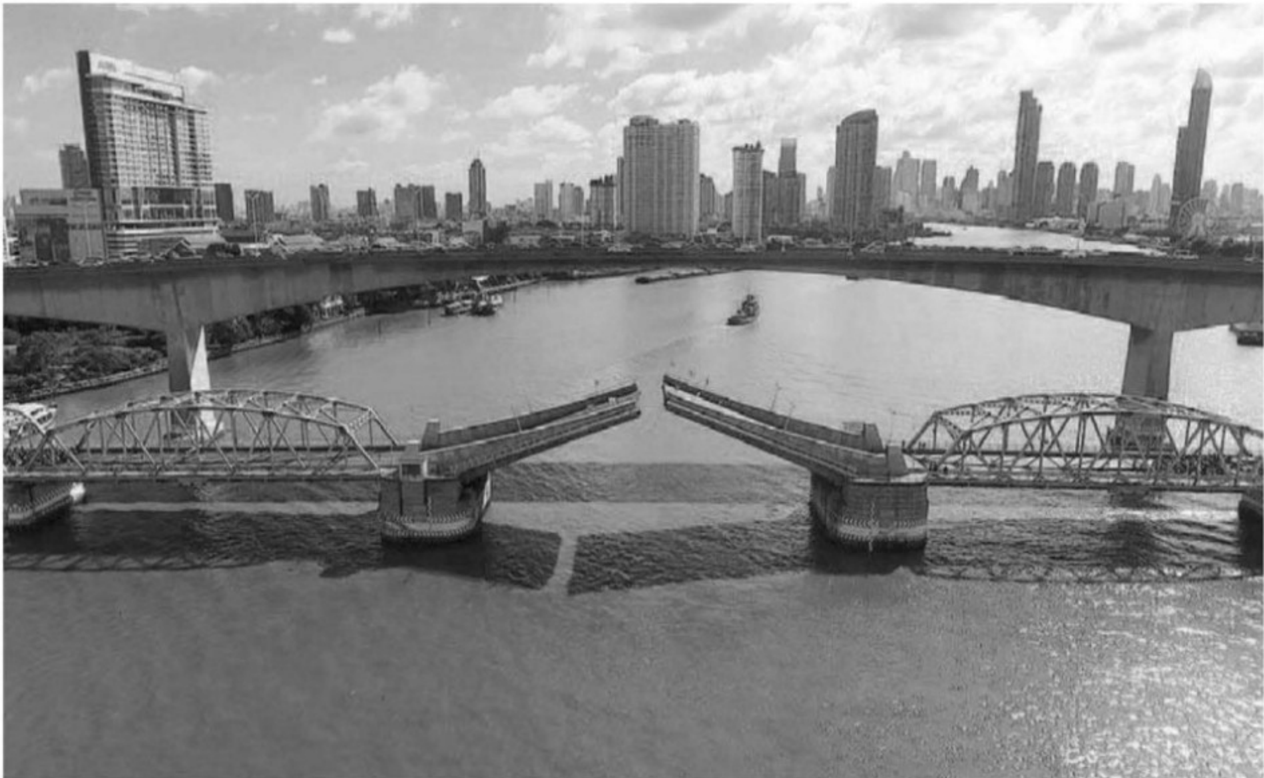
ซ่อมบำรุง : กรมทางหลวงชนบท (ทช.) โดยสำนักบำรุงทาง จะดำเนินโครงการบูรณะทางหลวงชนบทสายหลัก สะพานกรุงเทพ จึงมีความจำเป็นต้องปิดการจราจร (ทุกช่องทาง) บนสะพานกรุงเทพ เพื่อตรวจสอบระบบปั๊มเปอร์ช่วงเปิด-ปิดสะพาน ในคืนวันพฤหัสบดีที่ 20 พ.ค.2564 ตั้งแต่เวลา 22.00 ถึง 04.00 น.ของวันรุ่งขึ้น จึงขอประชาสัมพันธ์ให้ผู้สัญจรผ่านสะพานกรุงเทพ หลีกเลี่ยงเส้นทางในวันและเวลาดังกล่าว
