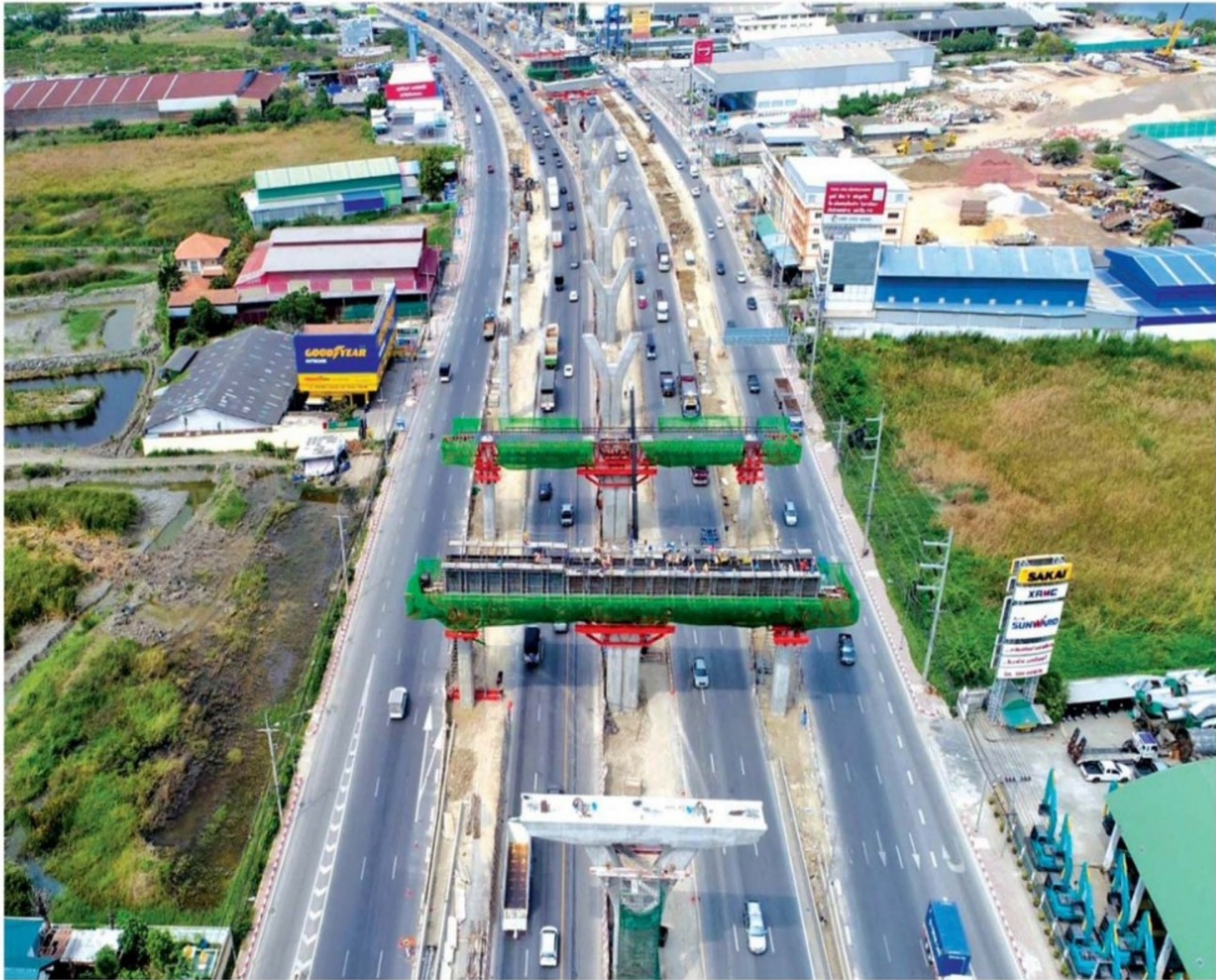
เสร็จปี 2565 - ภาพความคืบหน้างานก่อสร้างทางยกระดับบนถนนพระรามที่ 2 ช่วงบางขุนเทียน-เอกชัย ที่กรมทางหลวงกำลังก่อสร้าง ตามสัญญาจะเสร็จเปิดใช้ในปี 2565 และในอนาคตเส้นนี้จะพัฒนาเป็นมอเตอร์เวย์พาดยาวไปถึงบ้านแพ้ว บรรเทาการจราจรภาคใต้
