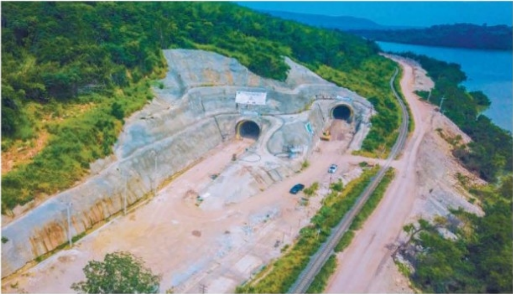
ยังอึด - ภาพความคืบหน้าการก่อสร้างรถไฟทางคู่ช่วงมาบกะเบา-จระ สัญญาที่ 3 งานอุโมงค์ ยังสร้างช้าจากแผน 9 เดือน ขณะที่ภาพรวมทั้งเส้นทาง ยังติดสัญญาที่ 2 ที่ต้องปรับแบบใหม่ และขออนุมัติงบก่อสร้างเพิ่มเติมจากคณะรัฐมนตรี
