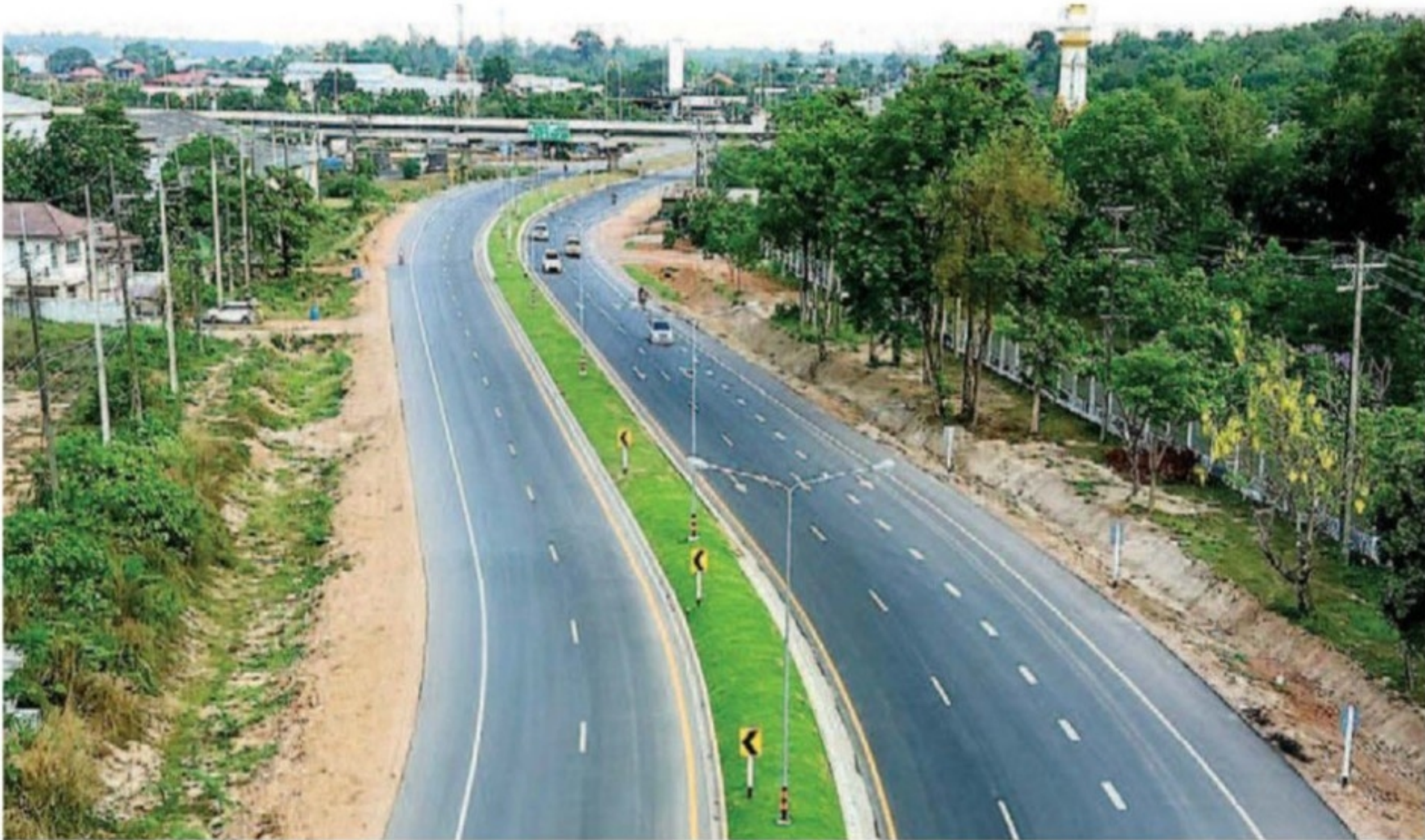
เสริมศักยภาพ : กรมทางหลวง โดยสำนักก่อสร้างทางที่ 2 ดำเนินโครงการก่อสร้างขยายทางหลวงหมายเลข 212 สายนครพนม-อ.ท่าอุเทน จ.นครพนม ระยะทาง 18.8 กิโลเมตร แล้วเสร็จ เพิ่มศักยภาพการคมนาคมขนส่งไทย-สปป.ลาว
