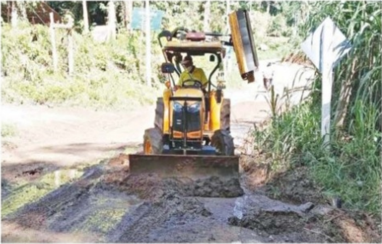
เกลี่ยดิน... เจ้าหน้าที่แขวงทางหลวงชนบทแม่ฮ่องสอน กรมทางหลวงชนบท (ทช.) นำเครื่องจักรปรับเกลี่ยหน้าดินและเคลื่อนย้ายกิ่งไม้ที่ปิดทับทางหลวงชนบทสาย มส.4012 แยกทางหลวงหมายเลข 1250-บ้านห้วยเสือเฒ่า ต.ผาบ่อง อ.เมือง จ.แม่ฮ่องสอน ที่ได้รับผลกระทบจากฝนตกต่อเนื่อง
