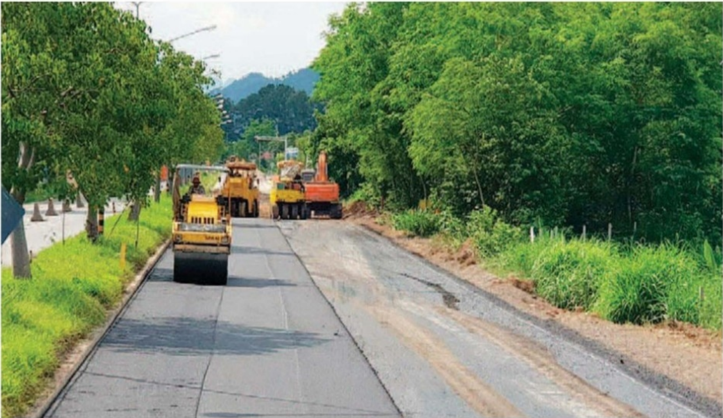
ซ่อมทาง: กรมทางหลวงชนบท (ทช.) ดำเนินโครงการซ่อมสร้างผิวทางลาดยางและปรับปรุงผิวทางลาดยางเดิม นำกลับมาใช้ใหม่ (HOT MIX In-Place Recycling แบบ RE-Paving) เพื่อให้การดำเนินงานซ่อมและปรับปรุงผิวทางเป็นไปด้วยความรวดเร็ว ส่งผลกระทบต่อการจราจรในพื้นที่น้อยที่สุด
