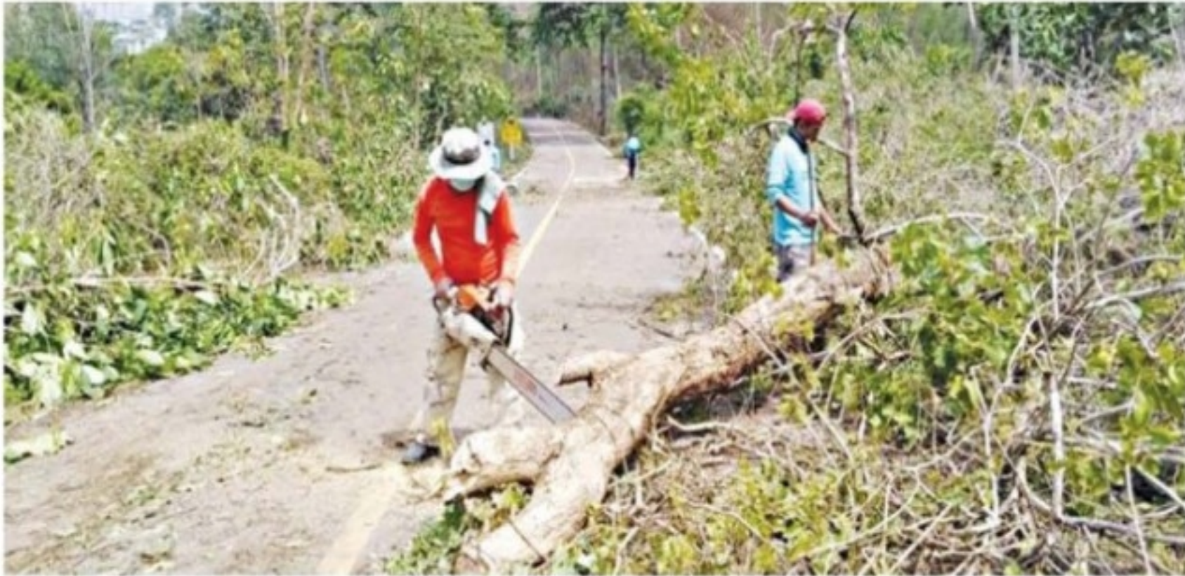
เคลียร์ทาง... เจ้าหน้าที่แขวงทางหลวงชนบทแม่ฮ่องสอน กรมทางหลวงชนบท (ทช.) นำเครื่องจักรตัดต้นไม้ที่ล้มทับกีดขวางเส้นทางการจราจรบนทางหลวงชนบทสาย มส.3007 แยกทางหลวงแผ่นดินหมายเลข 108-บ้านแม่สุริน อ.ขุนยวม จ.แม่ฮ่องสอน ช่วง กม.ที่ 42+200 ถึง กม.ที่ 48+100 จากลมพายุกระโชกแรงและมีฝนตกหนักในพื้นที่ เพื่อบรรเทาความเดือดร้อนให้ประชาชนสัญจรได้อย่างปลอดภัย
