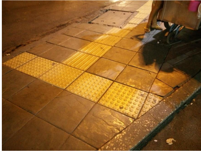
ภาพที่ 147 พื้นผิวต่างสัมผัสที่ไม่สามารถใช้งานได้อย่างมีประสิทธิภาพ
