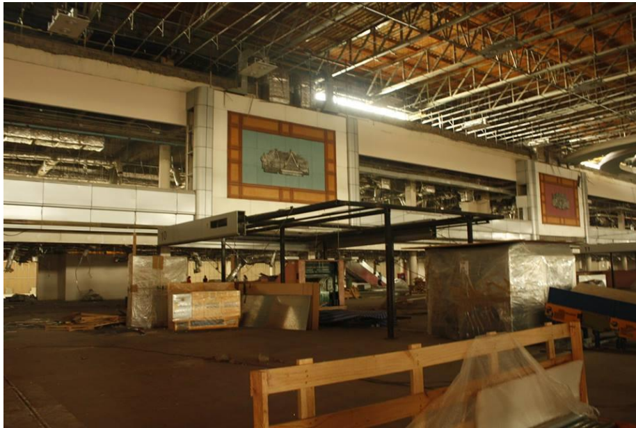
ภาพที่ 169 พื้นที่อาคารผู้โดยสารในประเทศ ท่าอากาศยานนานาชาติดอนเมืองอยู่ระหว่างการก่อสร้าง
