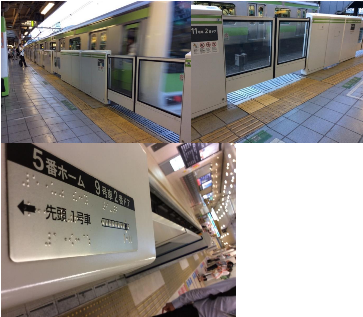
ภาพที่ 64 บริเวณชานชาลามีประตูกันอัตโนมัติที่มีความกว้างของบานคู่กว้างกว่าประตูตู้โดยสาร เพื่อไว้สำหรับ กรณีรถไฟมาจอดเทียบอาจไม่ตรงกับประตูตู้โดยสาร และมีการให้ข้อมูลเป็นอักษรเบรลล์บนแผงกัน สำหรับคนตาบอด
