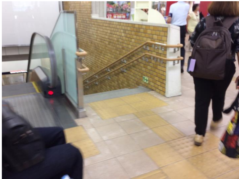
ภาพที่ 46 ติดตั้งราวจับสองระดับความสูง ในจุดที่มีความต่างระดับของพื้น เพื่อไว้สำหรับเด็ก หรือ คนที่มีความสูงน้อยกว่าคนทั่วไป
