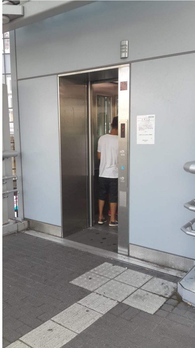
ภาพที่ 13 ลิฟต์ซึ่งมีผิวต่างสัมผัสสำหรับเตือนและนำทางคนพิการทางการเห็น และปุ่มกดระดับต่ำสำหรับ คนพิการที่นั่งรถเข็นใน Odaiba
