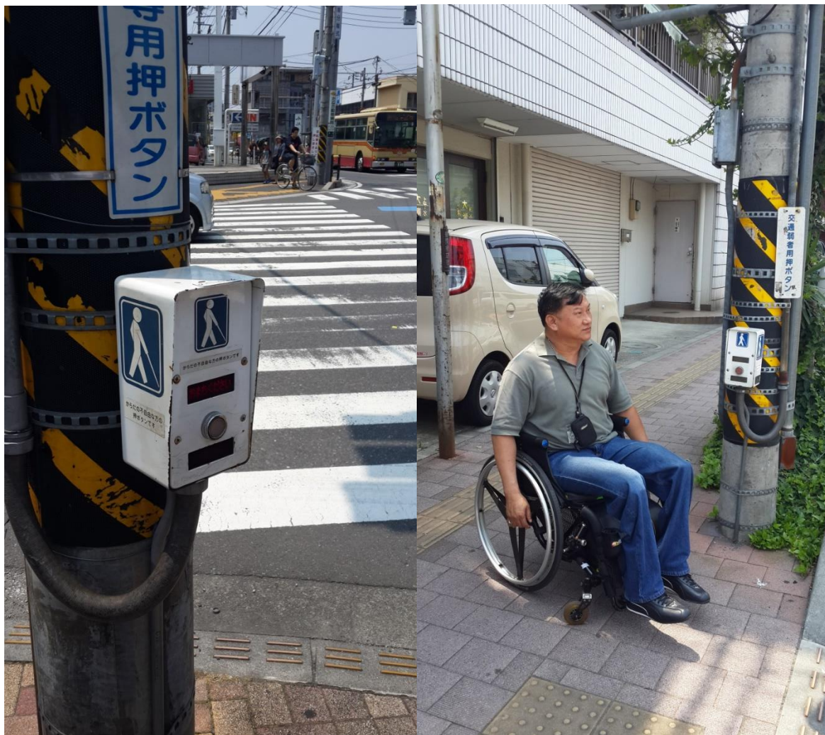
ภาพที่ 15 ปุ่มกดสัญญาณไฟข้ามถนนสำหรับคนพิการทางการเห็นซึ่งติดตั้งในระดับที่คนพิการที่ใช้รถเข็นสามารถกดได้ด้วยในเมือง Yamato
