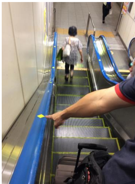
ภาพที่ 51 การเพิ่มจุดลงไปในราวจับบันไดเลื่อน ช่วยให้เข้าใจง่ายว่าทิศทางของบันไดเลื่อน กำลังขึ้นหรือลง (ใช้กรณีที่หน้าบันไดเลื่อนไม่มีสัญลักษณ์บอกทิศทางขึ้นลงของบันไดนั้น)
