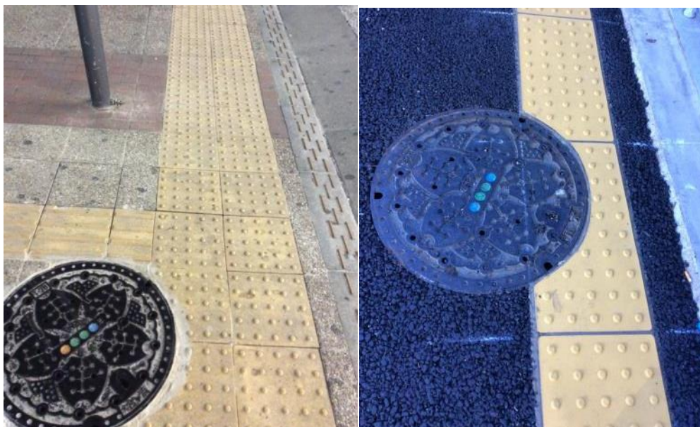
ภาพที่ 32 ผิวต่างสัมผัสแบบเตือน (Tactile pavement: warning blocks) ให้ระวังอุปสรรค หรือ มีความต่างระดับบนทางเท้า
