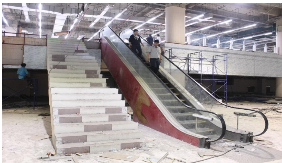
ภาพที่ 192 บันไดและบันไดเลื่อนระหว่างชั้น 1 และชั้น 2 สำหรับผู้โดยสารขาเข้า ซึ่งอยู่ระหว่างการก่อสร้าง
