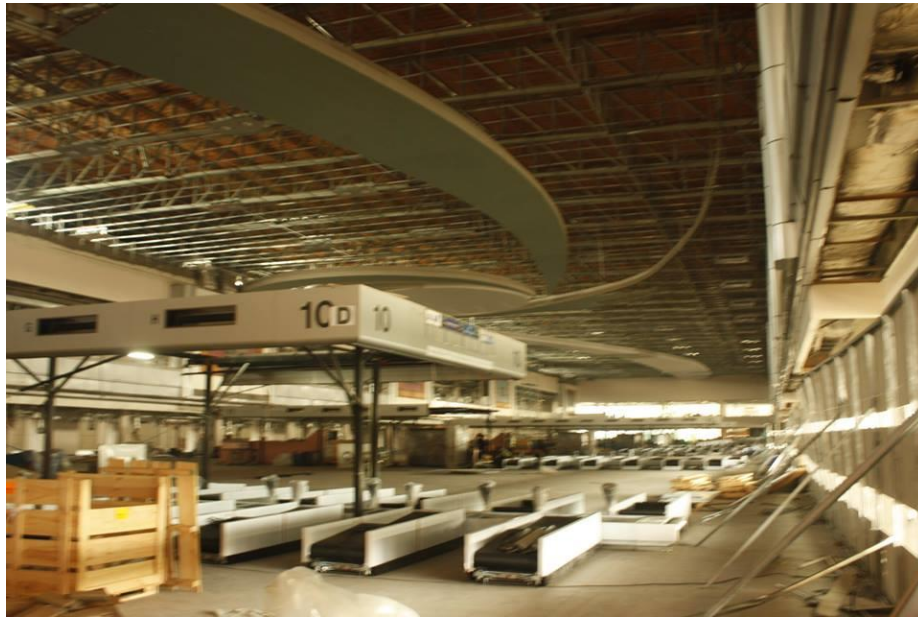
ภาพที่ 171 พื้นที่อาคารผู้โดยสารในประเทศ ท่าอากาศยานนานาชาติดอนเมืองอยู่ระหว่างการก่อสร้าง
