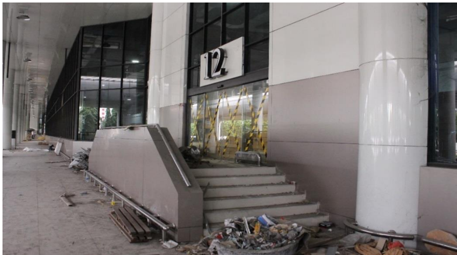
ภาพที่ 173 พื้นที่จอดรถรับ-ส่งสำหรับคนพิการและผู้สูงอายุซึ่งอยู่ระหว่างการก่อสร้าง
