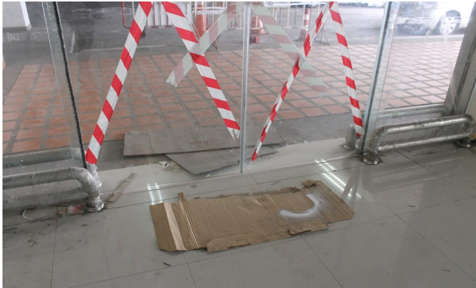
ภาพที่ 178 ประตูทางเข้าและทางออกที่จอดรถชั้น 4 ซึ่งอยู่ระหว่างการก่อสร้าง
