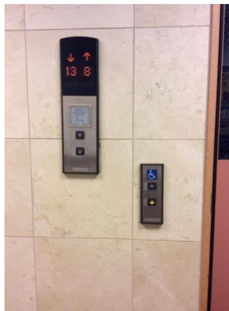
ภาพที่ 47 แผงควบคุมลิฟต์ มีปุ่มกดสองระดับ หรือระดับเดียว ในระยะความสูงจากพื้น 1.00-1.20 เมตร เพื่อให้ใช้ได้ทุกคนที่มีระยะเอื้อมไม่เท่ากัน เช่น จากที่นั่งในรถเข็นคนพิการ หรือ ทำยืนของคนทั่วไป
