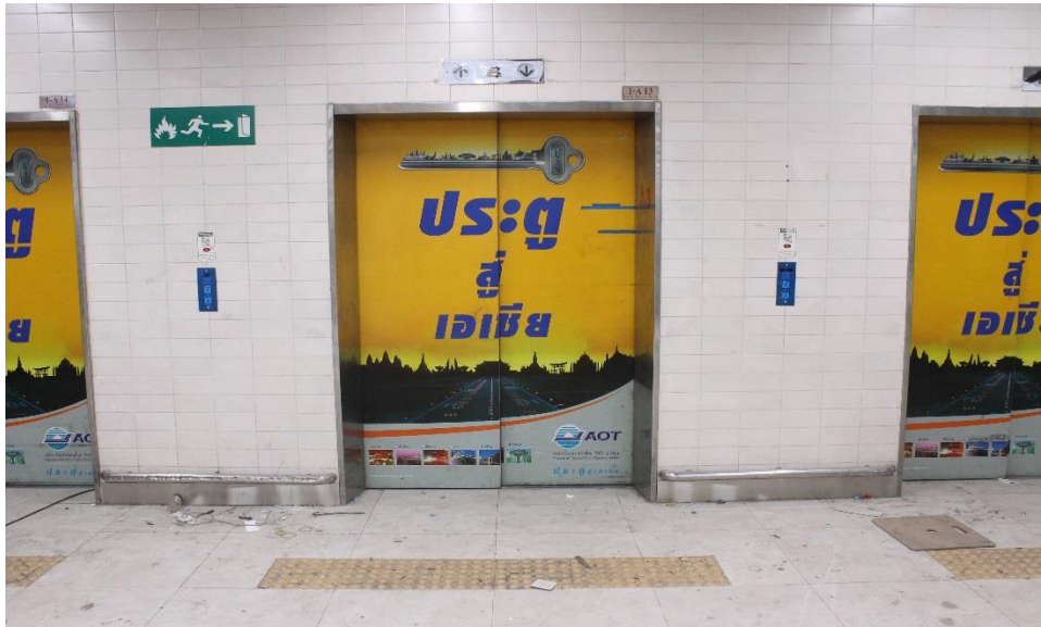
ภาพที่ 185 อาคารผู้โดยสารอาคาร 2 ชั้น 3 บริเวณหน้าลิฟต์โดยสารซึ่งอยู่ระหว่างการก่อสร้าง
