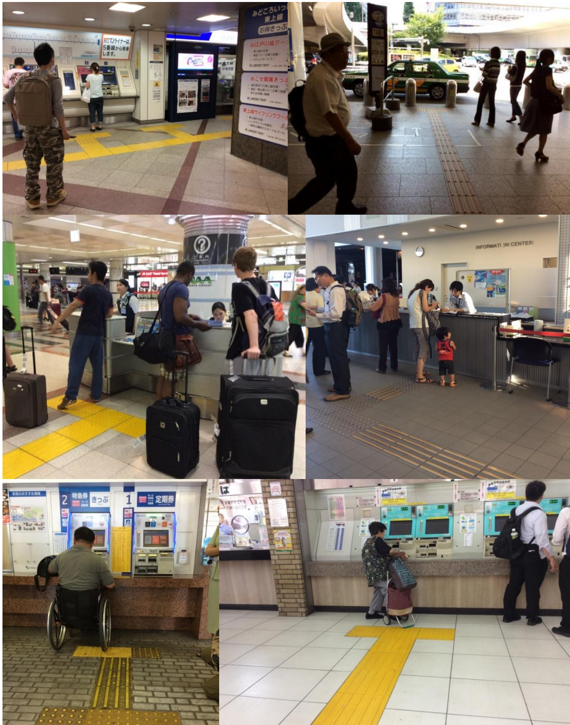
ภาพที่ 29 การใช้ระบบให้ข้อมูลบนทางเท้าด้วยผิวต่างสัมผัส (Tactile pavement) เพื่อนำทางไปสู่จุดให้บริการสำคัญในอาคารสถานที่นั้นๆ เช่น ทางเข้าหลักของอาคาร ทางไปสู่จุดขึ้นลงรถ ทางไปสู่เคาน์เตอร์ประชาสัมพันธ์ หรือเครื่องขายตั๋วอัตโนมัติ เป็นต้น
