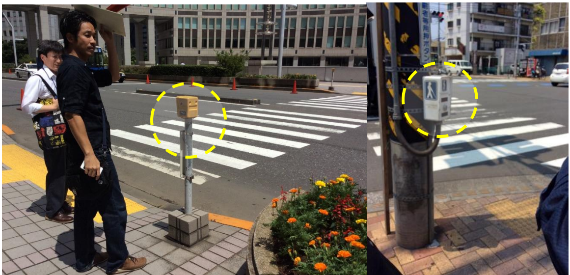
ภาพที่ 53 ระบบให้สัญญาณข้ามถนนเมื่อรถจอดด้วยเสียง สำหรับคนตาบอด ตาเลือนราง มีความสูงของปุ่มกด ระหว่าง 1.00-1.20 เมตร
