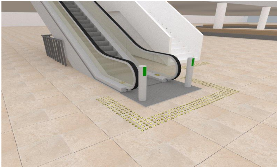
ภาพที่ 194 การติดตั้งผิวต่างสัมผัสเตือน และระบบเสียงสัญญาณเตือนบริเวณทางออกจากบันไดเลื่อนชั้น 1 ที่เสนอให้ทำการปรับปรุง
