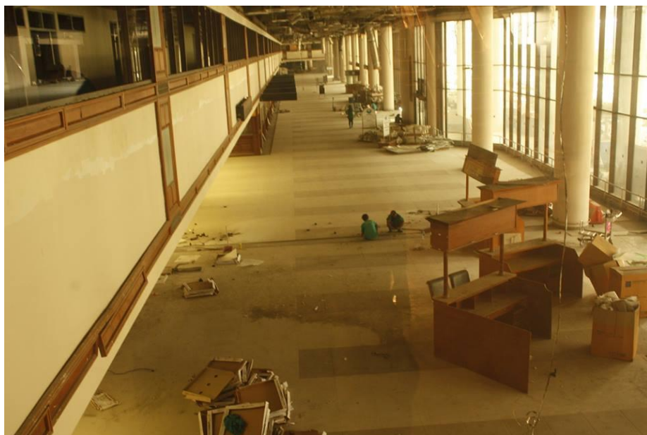
ภาพที่ 172 พื้นที่อาคารผู้โดยสารในประเทศ ท่าอากาศยานนานาชาติดอนเมืองอยู่ระหว่างการก่อสร้าง
