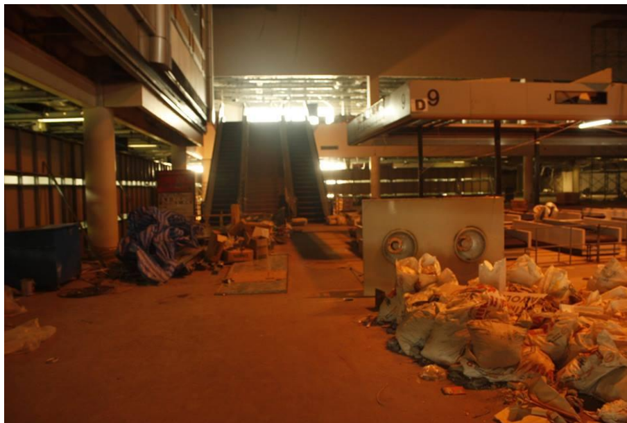
ภาพที่ 170 พื้นที่อาคารผู้โดยสารในประเทศ ท่าอากาศยานนานาชาติดอนเมืองอยู่ระหว่างการก่อสร้าง
