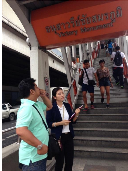
ภาพที่ 126 ภาพราวจับสำหรับผู้สูงอายุหรือคนพิการทางการเคลื่อนไหว บริเวณสถานีรถไฟฟ้าบีทีเอสอนุสาวรีย์ชัยสมรภูมิ
