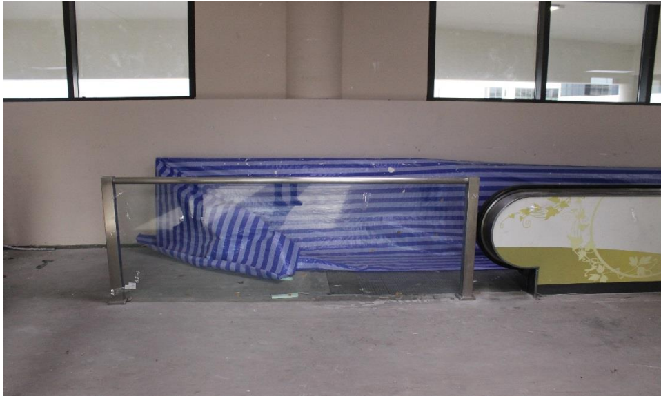
ภาพที่ 188 ทางเลื่อนบริเวณชั้น 2 ซึ่งอยู่ระหว่างการก่อสร้าง
