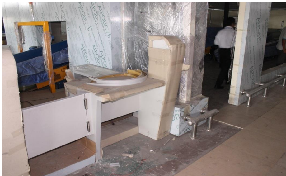
ภาพที่ 182 เคาน์เตอร์ใช้คีนซึ่งอยู่ระหว่างการก่อสร้าง
