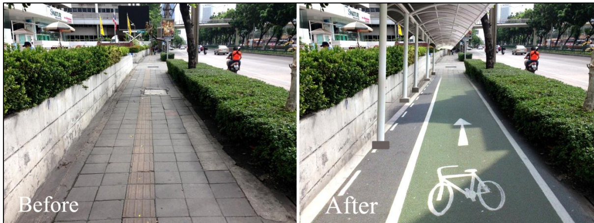
รูป 3.5-8 โครงการปรับปรุงผิวทางเดินเท้า และโครงการจัดสร้างทางจักรยาน
