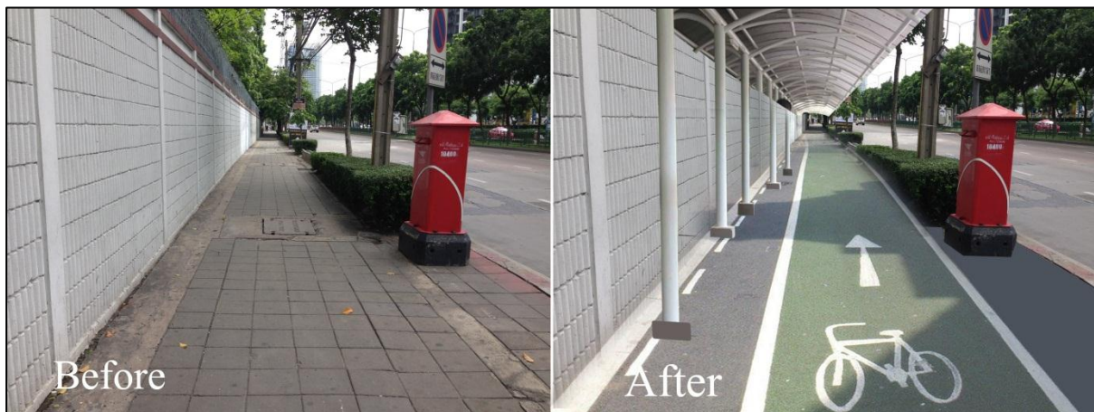
รูป 3.5-9 โครงการปรับปรุงผิวทางเดินเท้า และโครงการจัดสร้างทางจักรยาน
