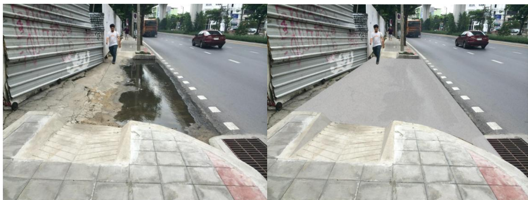
รูป 3.5-26 โครงการปรับปรุงทางลาดสำหรับคนพิการ
