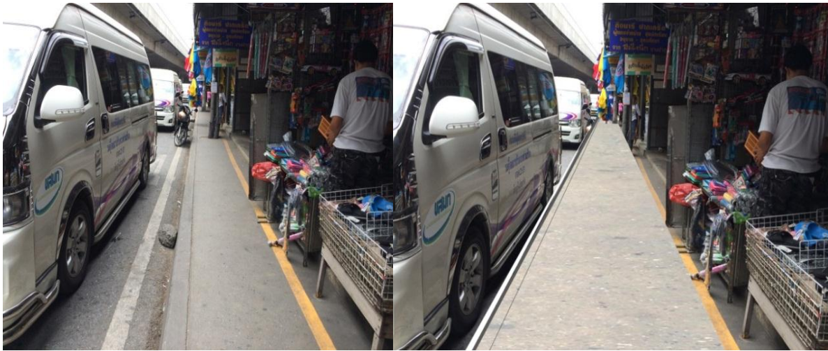
รูป 3.5-5 โครงการขยายทางเท้า
