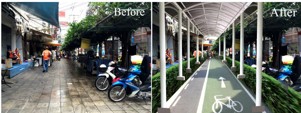
รูป 3.5-28 โครงการปรับปรุงผิวทางเท้า และโครงการก่อสร้างทางจักรยาน
