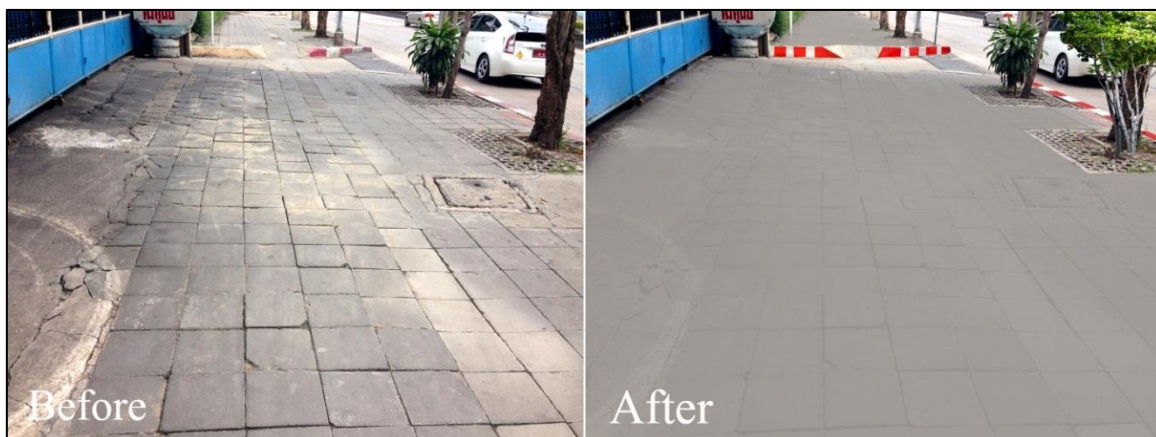
รูป 3.5-23 โครงการปรับปรุงผิวทางเดินเท้า และโครงการจัดสร้างทางจักรยาน
