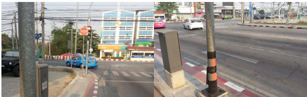
การปรับปรุงเครื่องหมายจราจรสำหรับคนข้ามถนน และการติดตั้งอุปกรณ์ Loop Detector ที่ทางแยกเคหะร่มเกล้า
