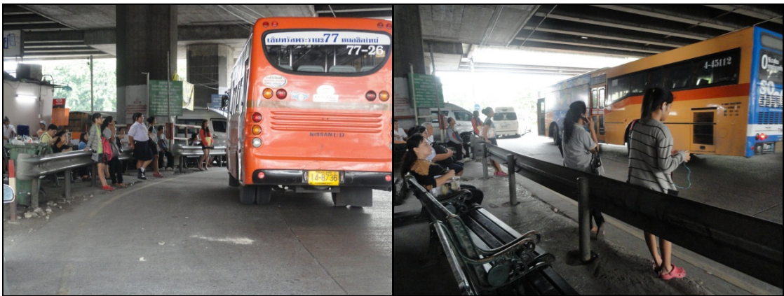
ติดตั้งราวกันอันตรายเพื่อป้องกันผู้โดยสารที่รอลงโดยสารถโดยสารประจำทางที่จุดกลับรถที่แยกถนนรัชดาภิเษกตัดถนนนพรี
