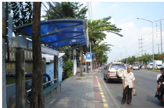
การปรับปรุงป้ายรถโดยสารประจำทาง บริเวณแยกนิด้าจนถึง กม.2+700 และบริเวณนิคมอุตสาหกรรมบางชัน (กม.5+500 ถึง กม.7+500)
