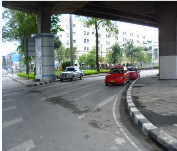
การก่อสร้างผิวทางเท้า บริเวณ กม. 4+300 บริเวณใต้ทางด่วนและสะพานข้ามแยกถนนลาดพร้าว
