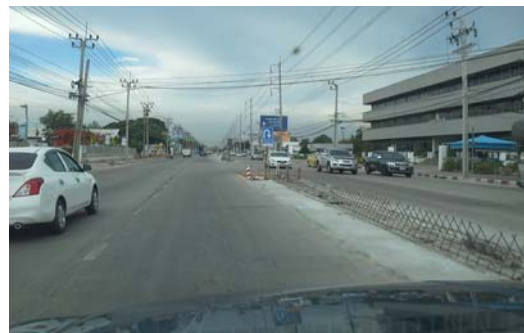
งานติดตั้งป้ายแนะนำจุดกลับรถ
