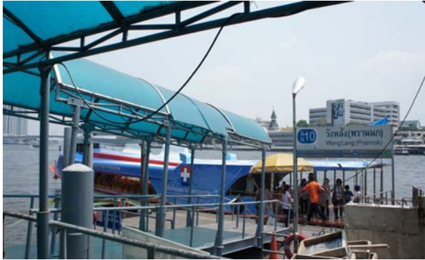
การติดตั้งหลังคาทางเดินเชื่อมที่ท่าเรือวังหลัง
