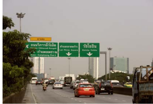
การจัดทำเครื่องหมายจราจรบนพื้นทาง และแก้ไขข้อความบนป้ายแนะนำบนถนนรัชดาภิเษก
