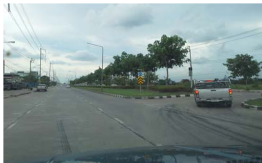
งานติดตั้งสัญญาณไฟกระพริบ 2 จุด
