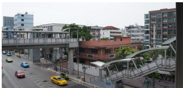
ทำทางเชื่อมระหว่างสะพานลอยบริเวณซอยกรุงธนบุรี 1 และสถานีรถไฟ บีทีเอส
