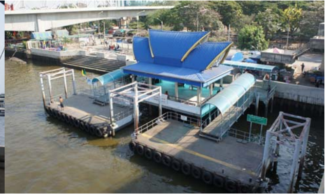
การก่อสร้างสถานีเรือโดยสารพระรามและ ติดตั้งหลังคาที่ทางเดินเชื่อมที่ท่าเรือพระราม 7
