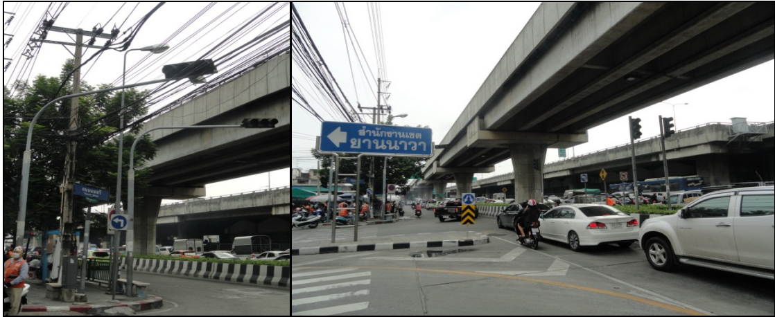
ทำการติดตั้งสัญญาณไฟจราจรเพิ่มเติมบริเวณแยกถนนรัชดาตัดถนนนพรี
