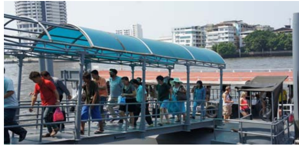
การติดตั้งหลังคาที่ทางเดินเชื่อมที่ท่าเรือท่าดินแดง
