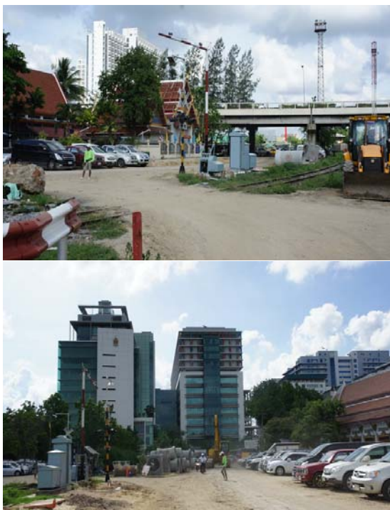
งานก่อสร้างปรับปรุงถนนรถไฟและถนนเลียบบคลองบางกอกน้อย
