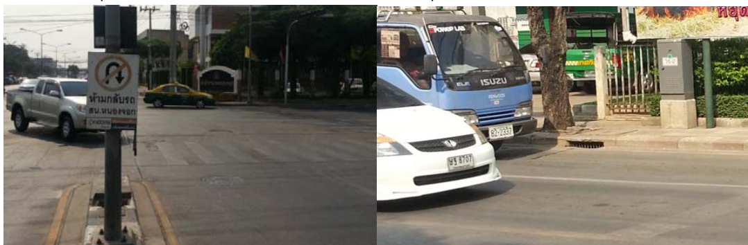
การปรับปรุงเครื่องหมายจราจร ห้ามกลับรถ และการติดตั้งอุปกรณ์ Loop Detector ที่ทางแยกหน้าทำการเขตหนองจอก
