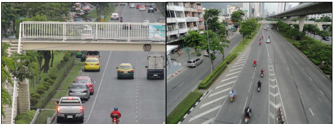
เปิดช่องทางออกจากถนนหลักออกสู่ถนนคูขนานและจัดช่องให้รถได้มีระยะทางของการรวมกระแสจราจรที่ถนนกรุงธนบุรี
