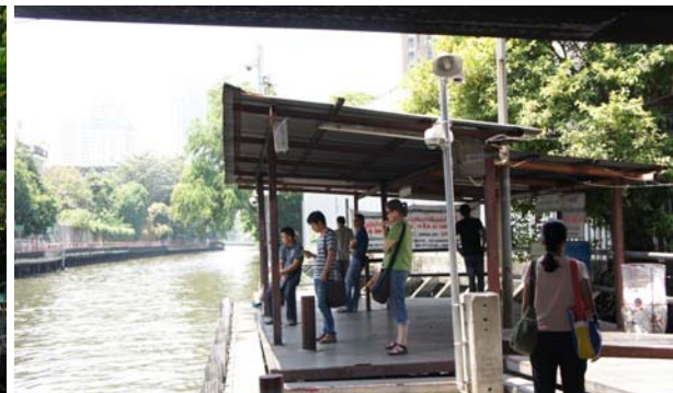
การติดตั้งหลังคากันแดดและฝืนที่ท่าเรือโคก
