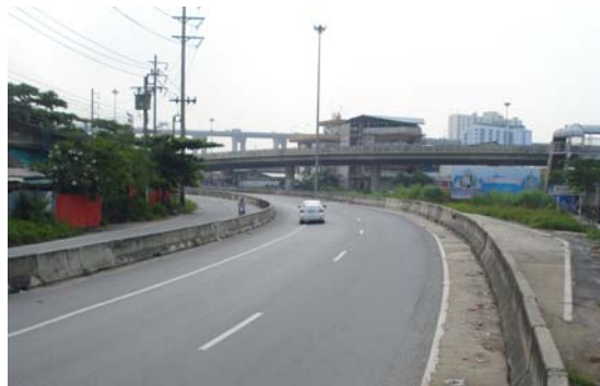
การ Leveling ด้วย Ac. บริเวณจุดขึ้น-ลงถนนวงแหวนกาญจนาภิเษก (ด้านใต้)
