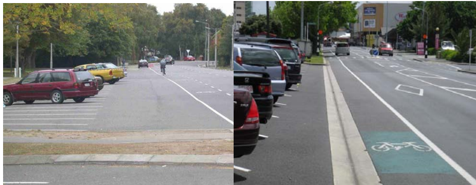
รูปที่ 2.179 การกันพื้นที่ระยะห่างระหว่างรถจอดมุมเฉียงกับช่องจราจรจักรยาน
