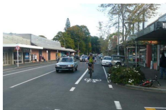
รูปที่ 2.16 ทางจักรยานแบบช่องจราจรจักรยาน (Bicycle Lane) กรณีห้ามจอดรถ (ซ้าย) และจอดรถได้ (ขวา)
