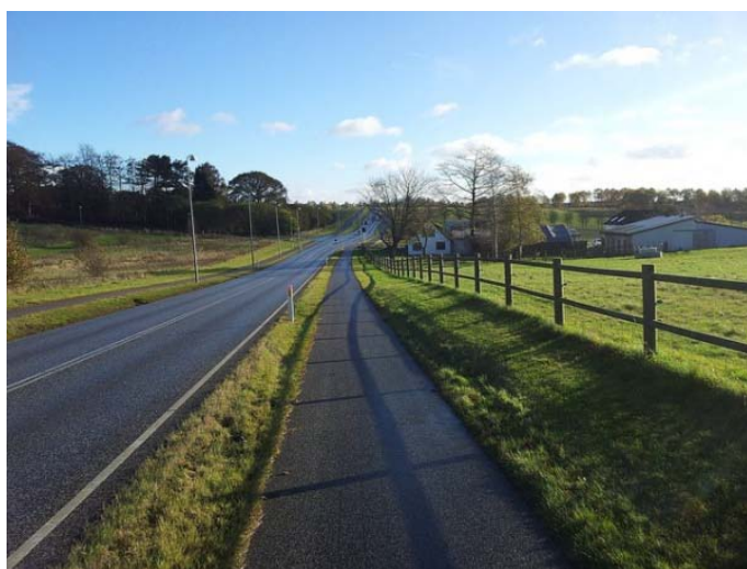
รูปที่ 2.8 การใช้พื้นที่กันเพื่อจัดพื้นที่เฉพาะสำหรับจักรยาน (Copenhageneize.com, 2013)
