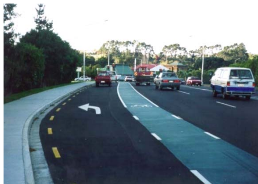
รูปที่ 2.20 กรณีที่ช่องจราจรจักรยานอยู่ระหว่างช่องจราจรทั้งด้านซ้ายและด้านขวา
