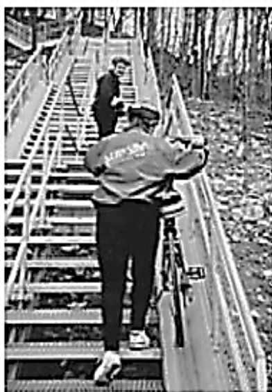
รูปที่ 3.6 แสดงรางสำหรับการขึ้นจักรยานขึ้นสะพานลอยคนเดินข้าม ที่มา : ที่มา : the Transportation Association of Canada (1999)
