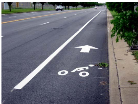
รูปที่ 2.16 ทางจักรยานแบบช่องจราจรจักรยาน (Bicycle Lane) กรณีห้ามจอดรถ (ซ้าย) และจอดรถได้ (ขวา)
