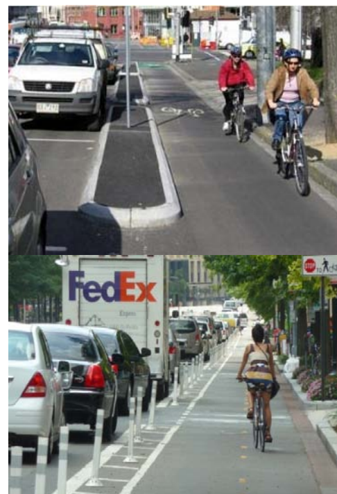
รูปที่ 2.22 ทางจักรยานแบบจัดทำพื้นที่กันชน (Buffer)
