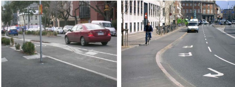
รูปที่ 2.23 ทางจักรยานแบบใช้ขอบคันหินหรือใช้พื้นที่ทางเท้า
