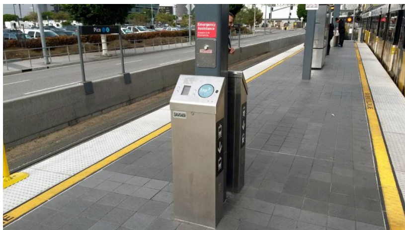
รูปที่ 32 เครื่องอ่านบัตร TAP ที่ทางเข้าสถานีที่ไม่มีประตูกันอัตโนมัติ สำหรับเปลี่ยนถ่ายผู้โดยสารที่สถานี Pico
