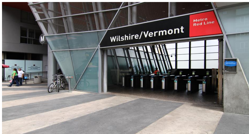
รูปที่ 35 สถานี Wilshire และ Vermont
