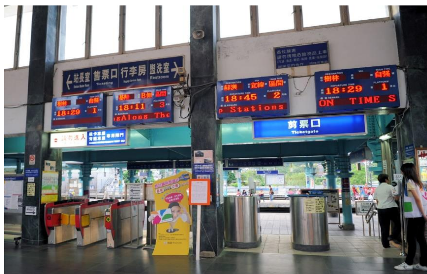
รูปที่ 3 ประตูกันและอุปกรณ์คิดค่าโดยสารอัตโนมัติของหน่วยงานบริหารจัดการระบบรางไต้หวันที่สถานี Buda
