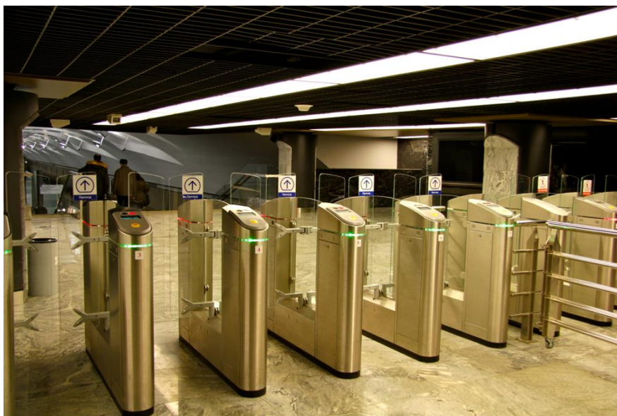
รูปที่ 13 อุปกรณ์กันทางเข้าสถานีรถไฟใต้ดิน Shipilovskaya
