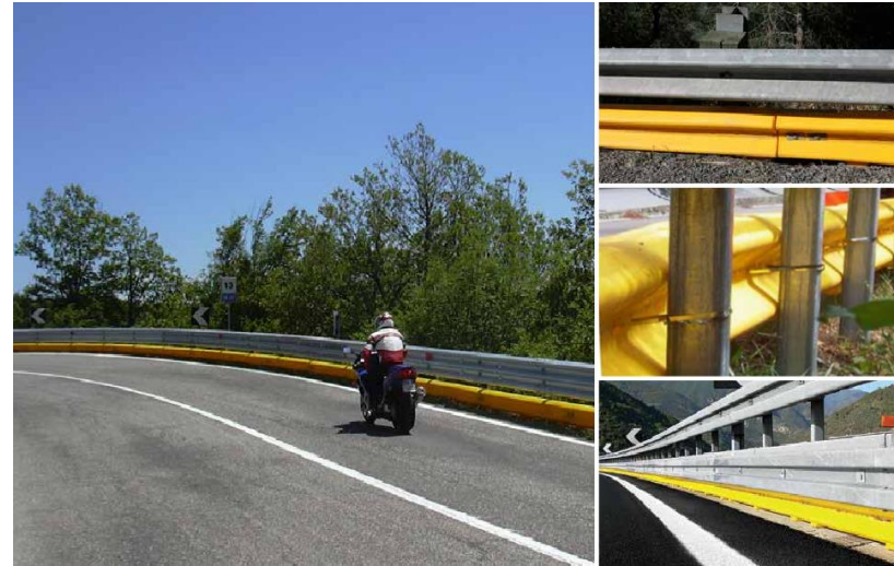
การติดตั้ง Guard rail สำหรับรถจักรยานยนต์
