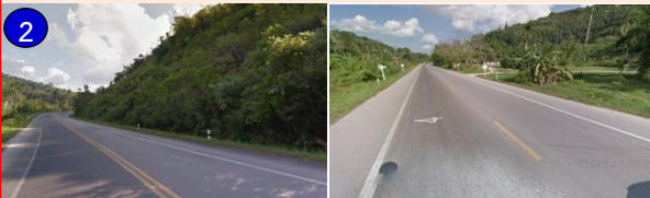
2 ทล. 4(ชุมพร-ระนอง ตอน 4) ปัจจุบันกำลังก่อสร้าง
