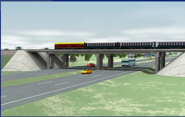
สะพานรถไฟข้ามถนนเดิม (Rail-over-Road Bridge)
