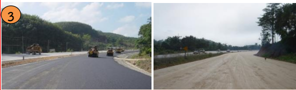
3 ทล. 4 ชุมพร-ระนอง ตอน 2) ปัจจุบันกำลังก่อสร้าง
