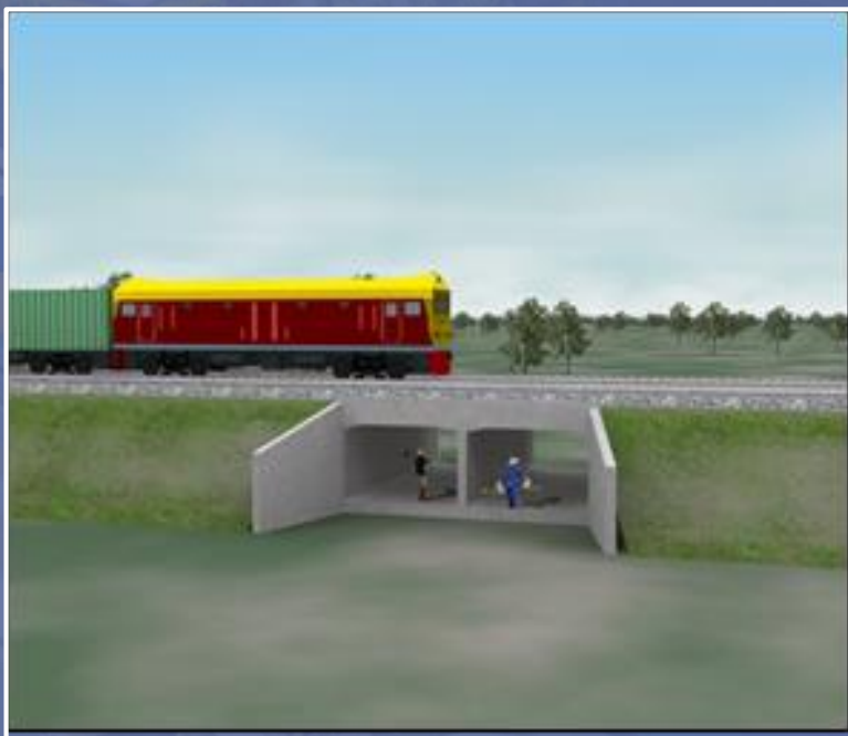
ทางลอดรถยนต์ชนิดท่อเหลี่ยม
