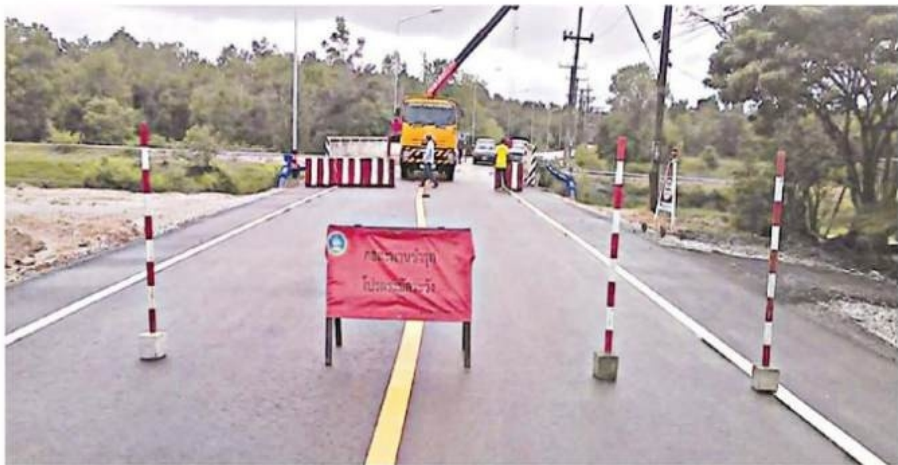
เร่งซ่อมถนน... แขวงทางหลวงชนบทนราธิวาส กรมทางหลวงชนบท (ทช.) นำเจ้าหน้าที่ซ่อมแซมถนนและปรับปรุงคอสะพานชำรุดจากอุทกภัย โดยนำหินคลุกถมบริเวณที่น้ำกัดเซาะผิวจราจร บนทางหลวงชนบทสาย นธ.4008 แยกทางหลวงแผ่นดินหมายเลข 4055-บ้านป่าไผ่ อ.ระแงง จ.นราธิวาส และทางหลวงชนบทสาย นธ.2005 แยกทางหลวงแผ่นดินหมายเลข 42-บ้านค่าย อ.เมือง จ.นราธิวาส
