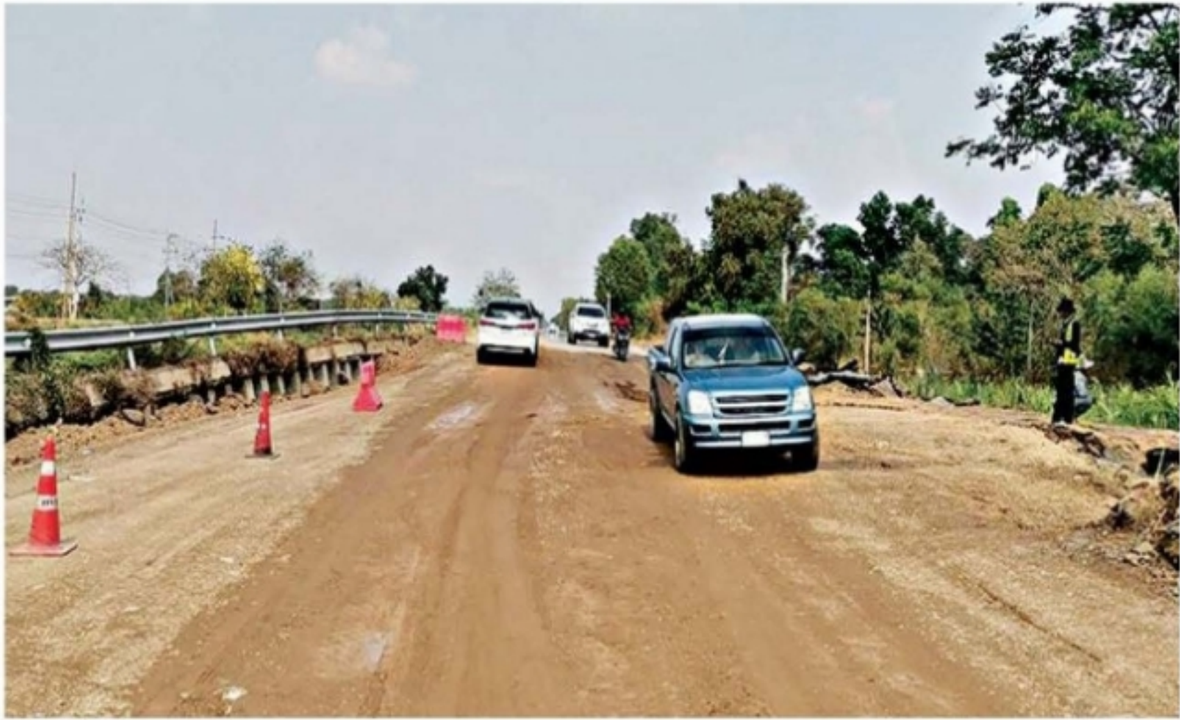
สัญจรชั่วคราว... แขวงทางหลวงชนบทปทุมธานี กรมทางหลวงชนบท นำเครื่องจักรขุดรื้อผิวทาง ปรับระดับชั้นทางเพื่อลดน้ำท่วมคันทางถนนทางหลวงชนบทสาย ปท.5021 อ.หนองเสือ จ.ปทุมธานี (ถนนเลียบคลองระพีพัฒน์) ป้องกันการทรุดตัวเพิ่มและเปิดสัญจรชั่วคราวบรรเทาความเดือดร้อนประชาชน หลังเกิดทรุดตัวลง 1 เมตร เนื่องจากกำแพงกันดินหักทำให้ผิวถนนชำรุดแตกตัวเป็นแอ่งลึกยาว 60 เมตร
