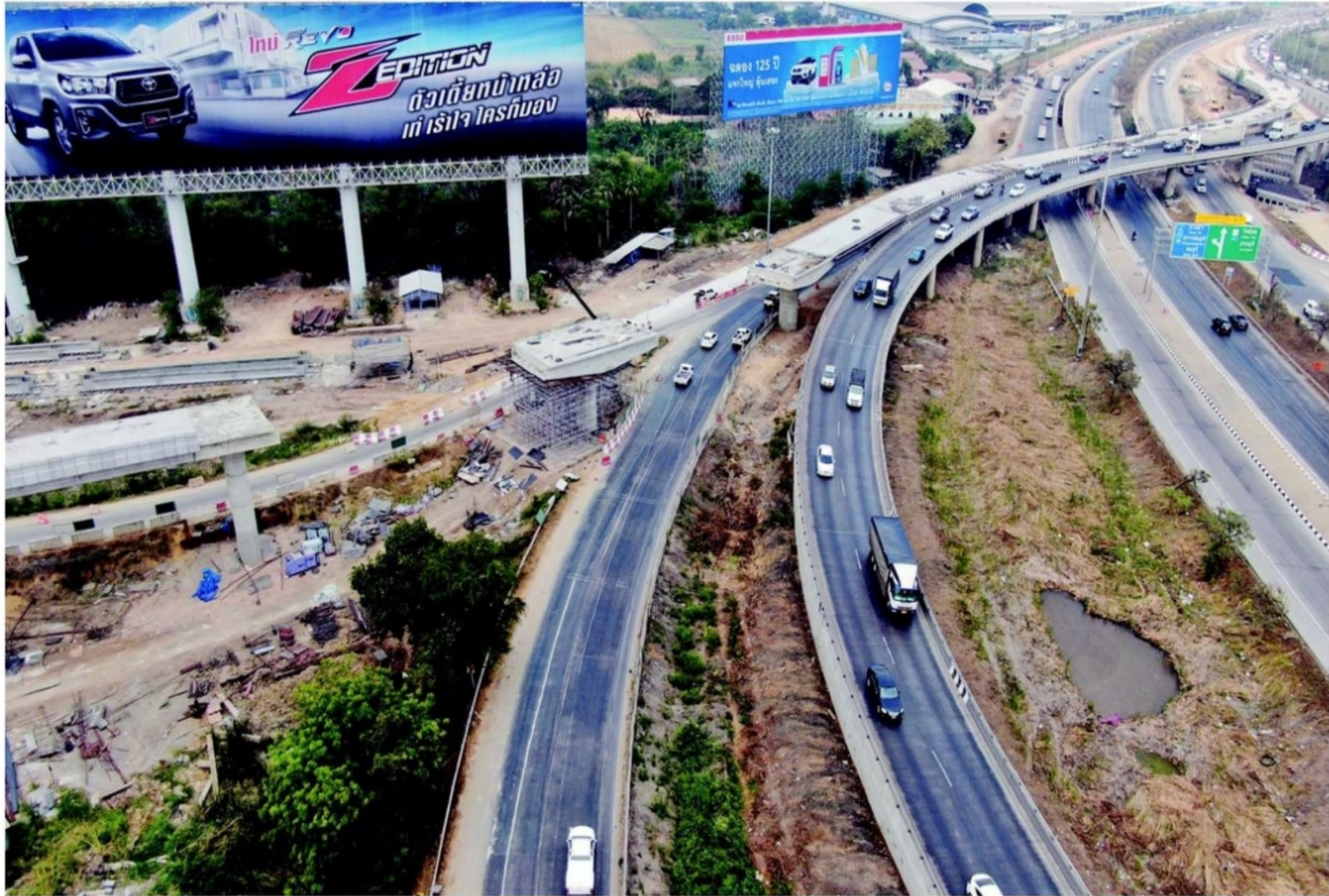
ต่างระดับบางปะอิน - ปัจจุบันกรมทางหลวงกำลังก่อสร้างทางต่อเชื่อมกับบริเวณทางแยกบางปะอิน ที่ในอนาคตจะเป็นจุดต่อเชื่อมกับมอเตอร์เวย์สายบางปะอิน-สระบุรี-นครราชสีมา ส่วนต่อขยายโกลด์เวย์รังสิต-บางปะอิน ที่คาดว่าจะมีปริมาณการจราจรเพิ่มขึ้นอีกมาก เพราะต้องรับรถจากวงแหวนตะวันตกและวงแหวนตะวันออกอีก
